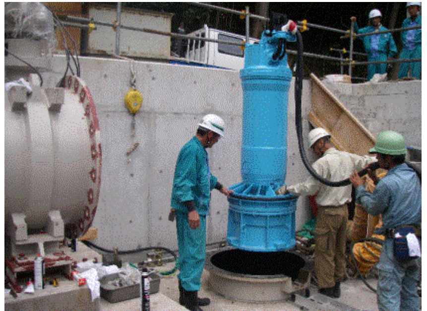
水中タービン発電機（吊り込み状況）
