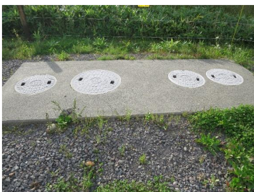
図 35 浄化槽の設置の事例
