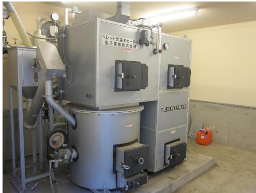
図 36 ペレット焚温水ヒーターの事例
