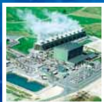
耐食・材料・熱水利用技術 地熱発電プラント
