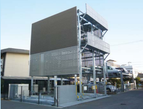
油圧3段・地上5段・地下2段 実機実験 (自社工場)
