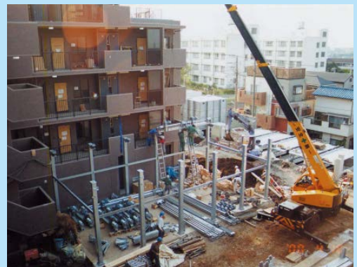
(自社施工管理)
