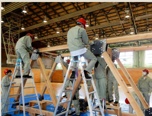
卒業研究で制作した災害時緊急仮設橋
