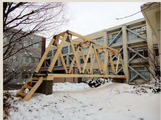
卒業研究で制作した災害時緊急仮設橋
