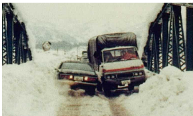
雪で道幅が狭く、すれ違いが困難
