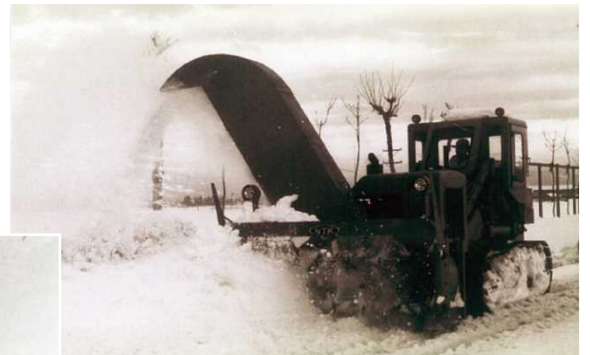
ロータリ除雪装置を 装着したショベルカー
