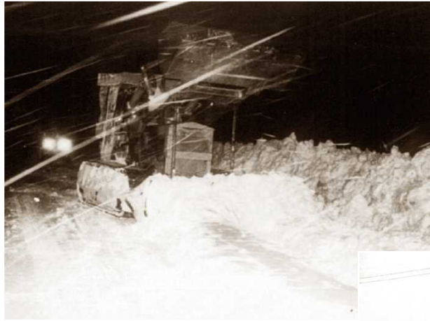
ブルドーザ による除雪
