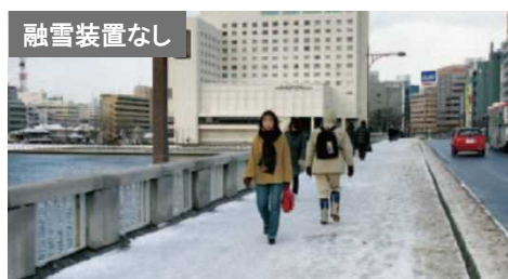
(国道7号萬代橋 新潟県新潟市)
