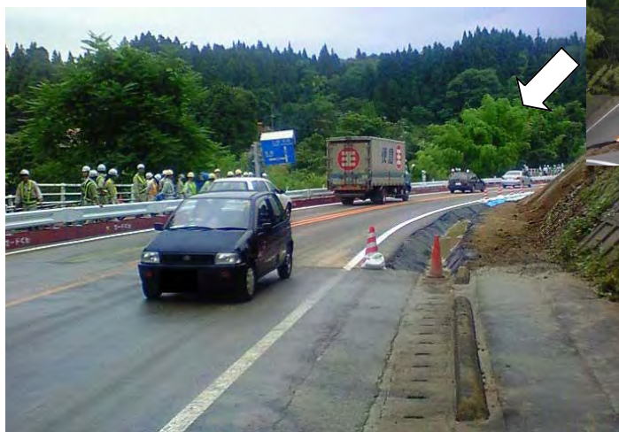
応急復旧により対面2車線通行確保(7月23日)
