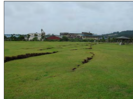
芝生広場ひび割れ
