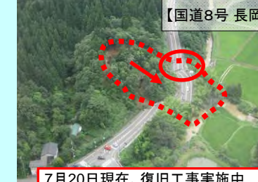
7月20日現在、復旧工事实施中 地すべり発生により道路が完全に寸断、路面は地震前から約6～10m陥没
