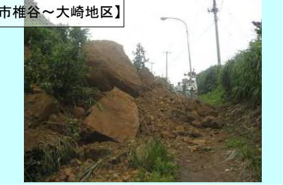
岩塊を含む崩壊土砂が道路に流出 道路照明灯付近に斜面を目視する専門家の姿
