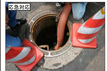
滞水している区間はバキューム車により応急対応
