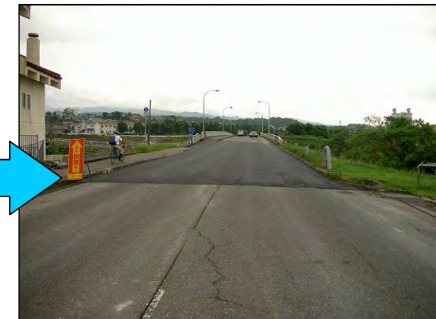
＜応急復旧完了 通行可＞
