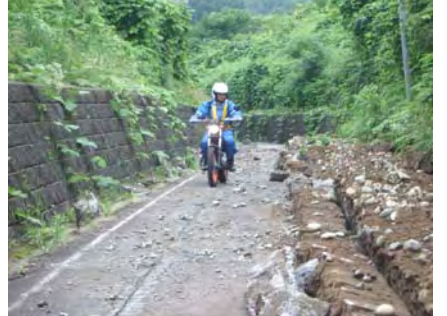
バイク調査隊による巡視点検状況(国道352号の並走道路)
