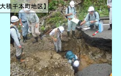
道路寸断箇所の亀裂を調査する(独)土木研究所の地すべり専門家
