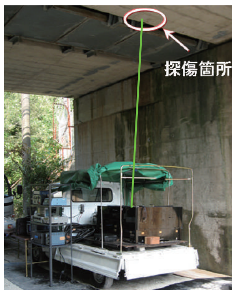
図3 山陽新幹線の第2滝ガ谷橋梁での実験
