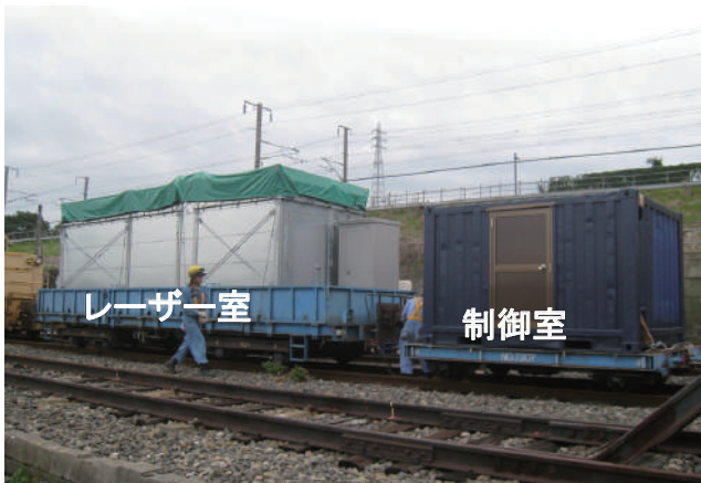
図5 新幹線トンネル内でのコンクリート欠陥検査実験
