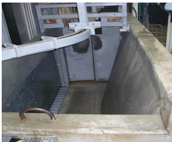
( コンクリート製の保定装置 )
