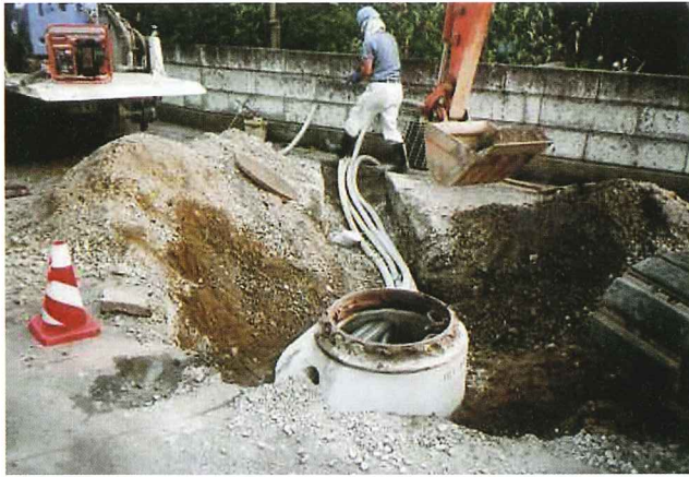
仮設配管状況 (φ50mm)
