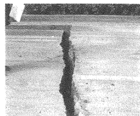
写真3 地点Aの地盤クラック状況 (クラック幅=15cm)
