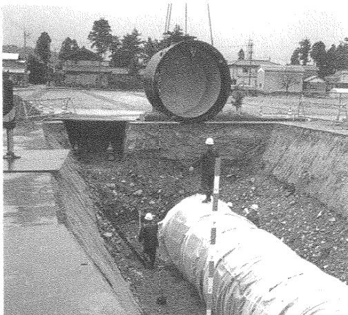
写真3 管布設工
