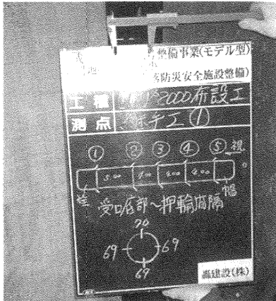
写真5 継手の胴付間隔のチェック
