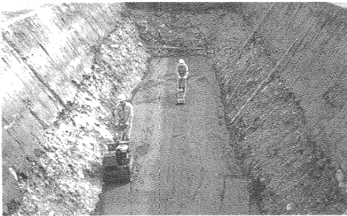
写真2 砂基礎転圧工
