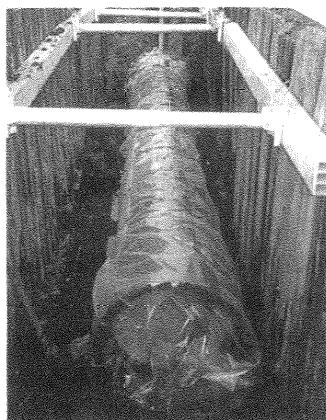
写真2 管布設状況（呼び径350mm）
