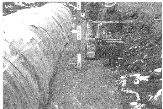
写真4 埋戻し転圧工
