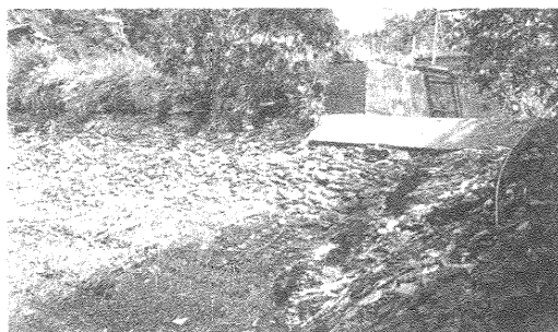
写真1 余水吐部 (現況)
