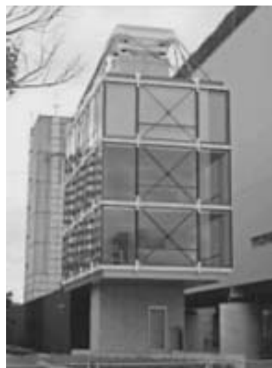
写真1 建物外観写真
