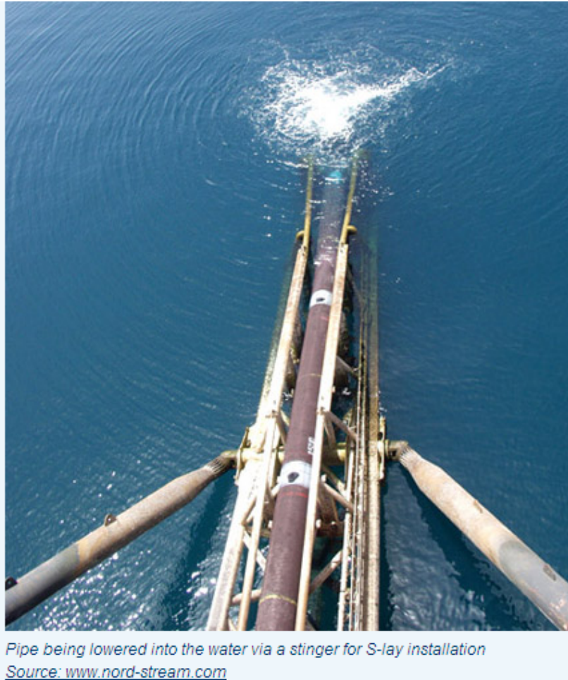
写真 S-lay 方式でスティンガーの上を水中へ送り出されるパイプ
