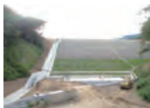
工事が進捗する堆積場 (2013年7月)
