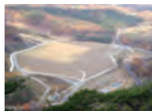
恒久対策工事が完了した堆積場 (2012年11月)
