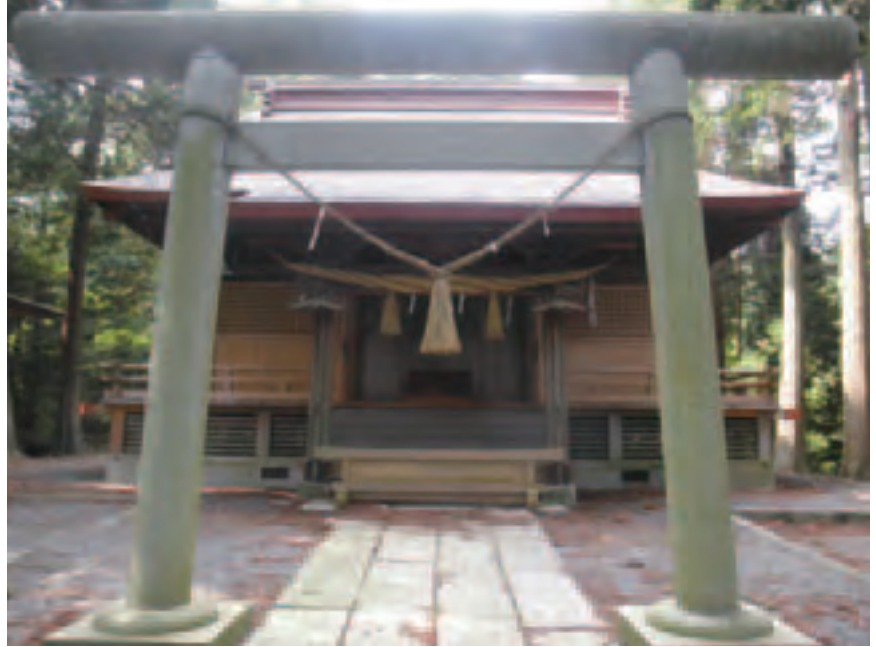
2011年に修繕工事を行った山神社
