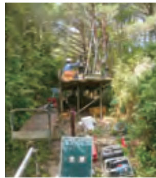
堆積場の建設現場
