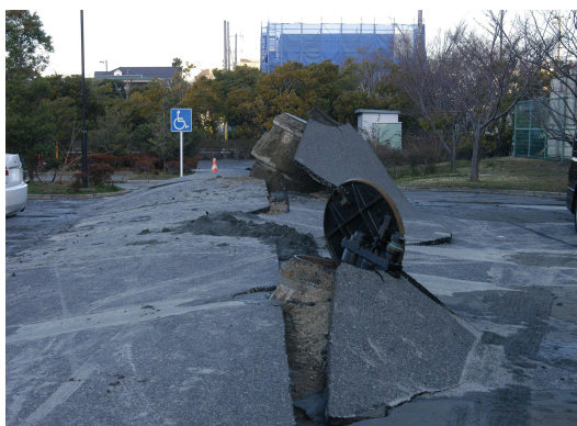
左 浦安市内の貯水タンクが地面から飛び出した写真 ( http://urayasu-shinsai-archive.city.urayasu.lg.jp/special/page_01/ ) 右 東日本大震災直後の東京ディズニーランドの写真 ( https://www.asahi.com/business/gallery/130411tdr/a63.html )
