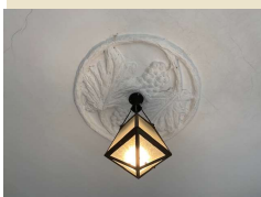
照明器具の設置
