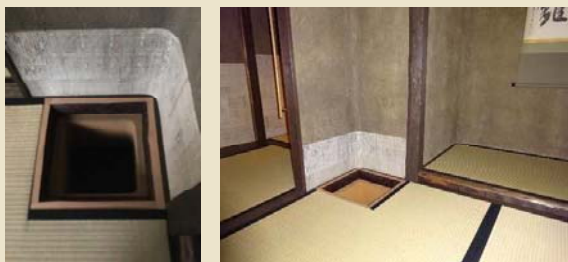
1尺3寸4分角の隅炉と5尺の床
