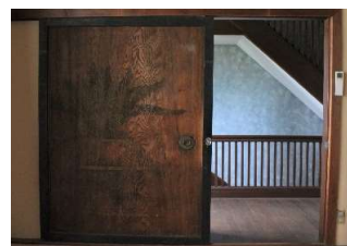
アトリエの入口、杉の一枚板による板戸が使用されている。
