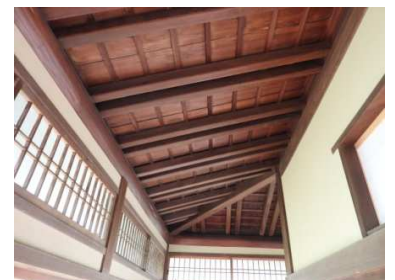
東縁 天井見上げ
