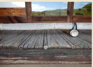
濡縁:新薬師寺の柱を転用
