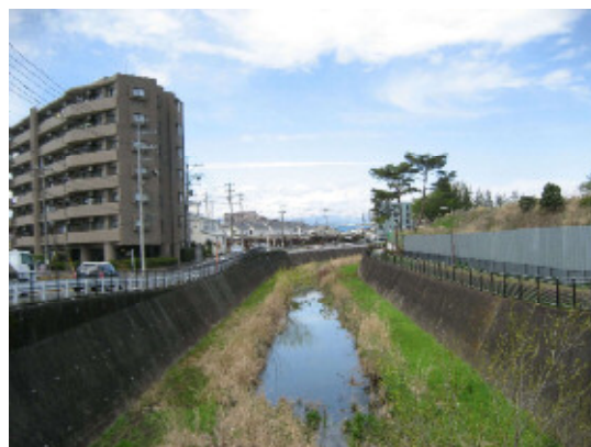
新残堀橋上流付近(立川市)
