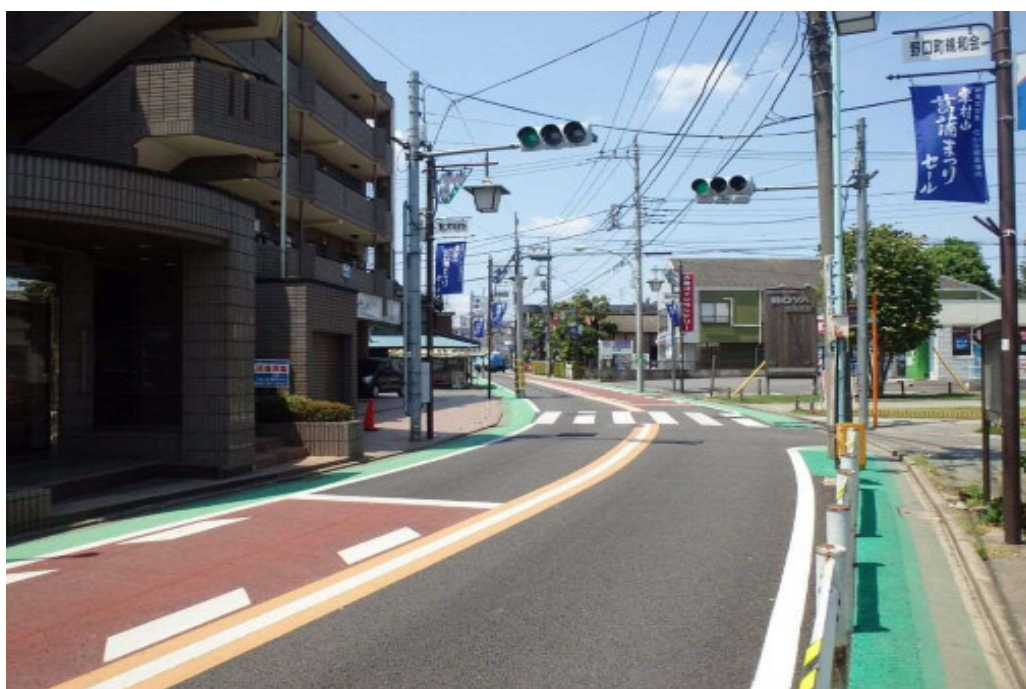
路面補修に合わせて交通安全対策を実施
