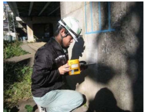
橋梁の点検状況
