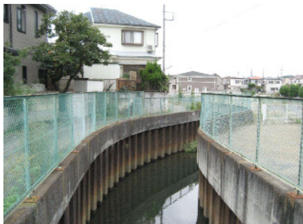
空堀川 念仏塚橋上流付近(未整備箇所、武蔵村山市)
