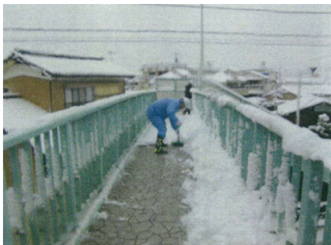
横断歩道橋の除雪作業
