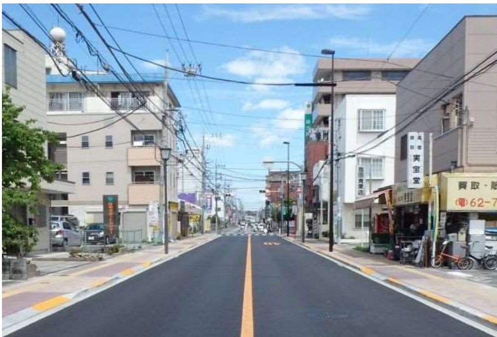
路面補修に合わせて歩道改善(歩道の前出し)を実施
