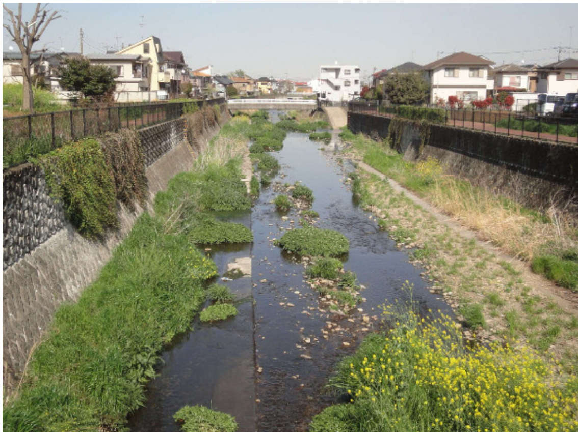
〔東大和市奈良橋五丁目 新庚申橋下流付近〕
