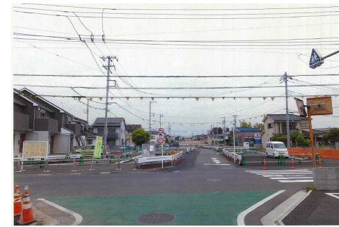
③終点側の状況
