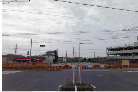
①既成側の状況
