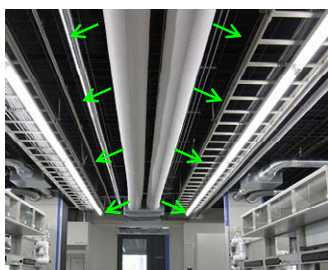
写真－3 微風速給気
