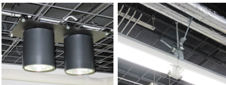
写真-8 設備マルチ天井への照明器具取付け
