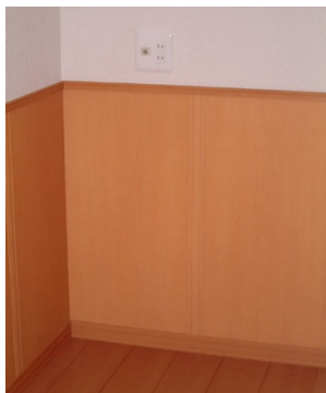
図 3.3.2 ペット用耐傷フローリングと耐傷性パネルで腰壁を設けた改善事例
