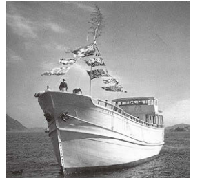
第一國華丸。当社建造第2隻目。木造機帆船にて苛性ソーダ専用船。119.31GT、170.00DWT
