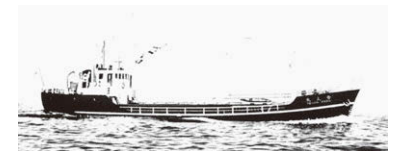
帝人丸。リバイバル船名の第一号。初代帝人丸と同じ二硫化炭素専用特殊タンク船であった。187.68GT、251.33DWT
