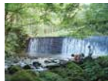
清水川第五堰堤
