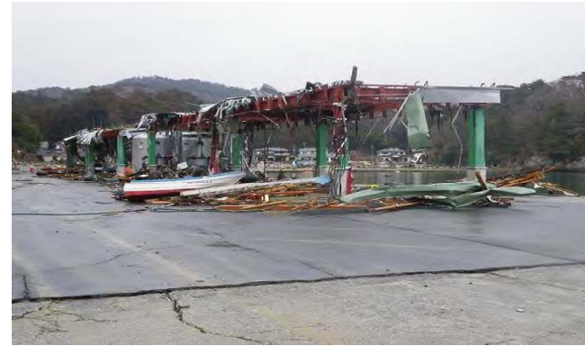
被災した養殖かき浄化施設(宮城県石巻市)
