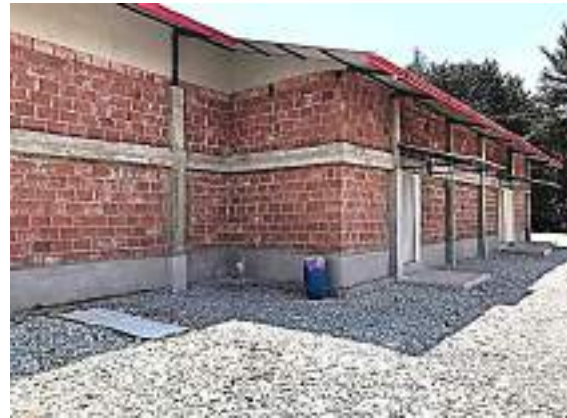
写真 9 B 社の新たに建設された加工工場の外観 (クスコ)
