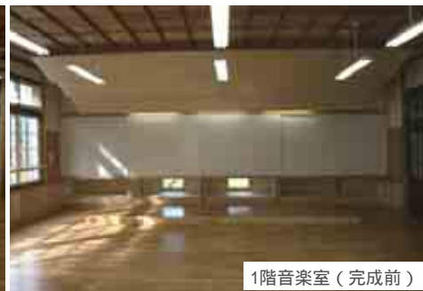
1階ランチルーム、音楽室(完成前)
