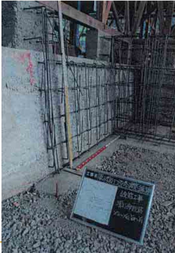
増打部配筋状況
