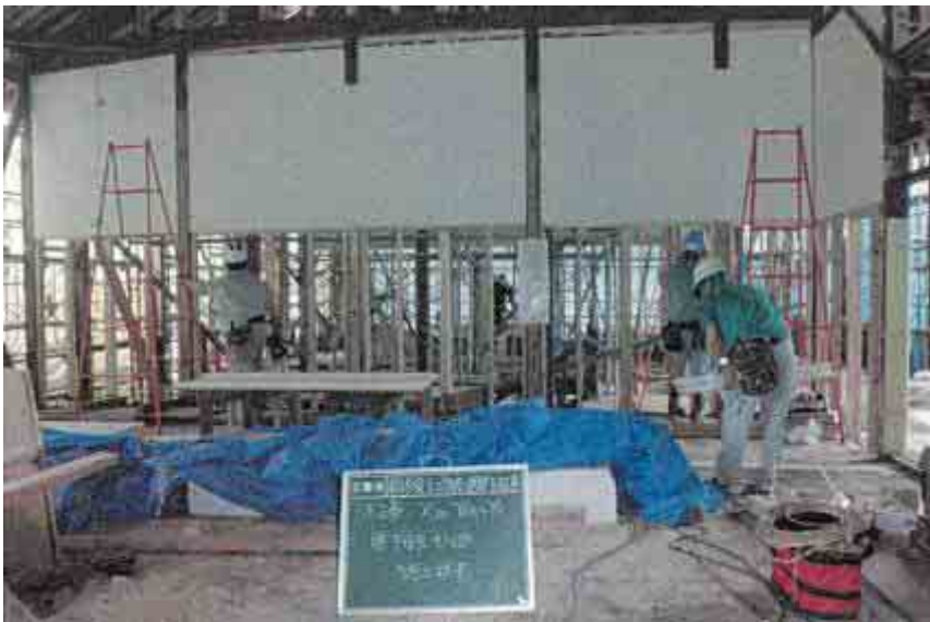
内部:TGR施工中
