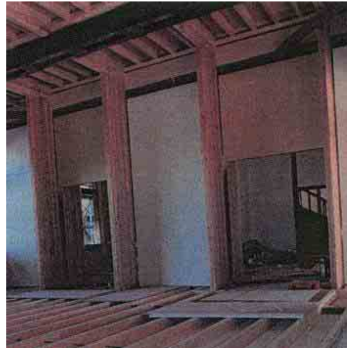
増設耐力壁: 集成材建込 WD1
