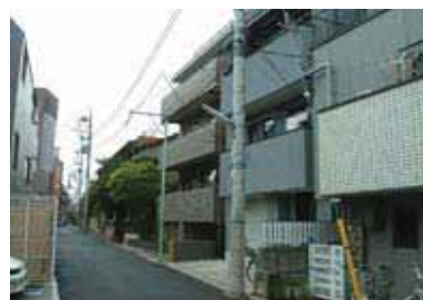
災害時も比較的避難可能な路地
