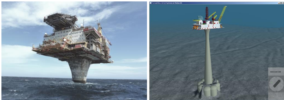
図 4.4.1 重力式固定構造物
