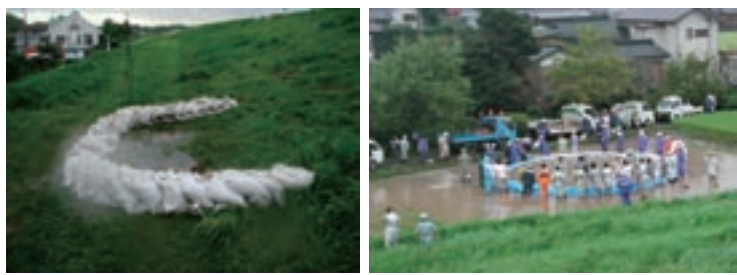
図表 2-5-11 平成13年9月堤防漏水状況（埼玉県加須市大越地先）
