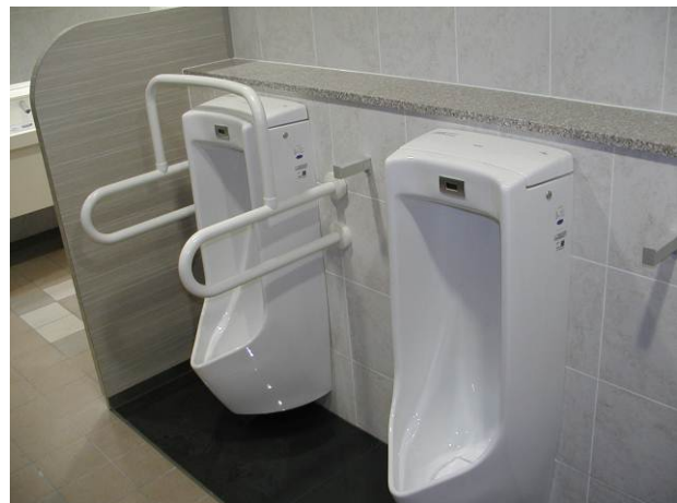
I 手すりの設置された男性用小便器 三か所の小便器のうち一か所に、手すりが設置している。
