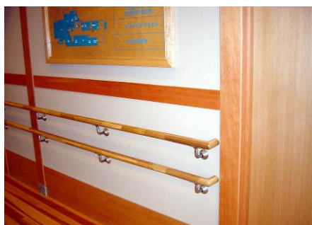
D 建物内廊下
