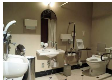
D 2階共用便所内の多機能便房 入口は自動ドアで内部はカーテンで間仕切る。手すり、感知センサー式洗浄ボタン、呼び出しボタンあり。 男性用便所の通路の途中に独立型の男女共用多機能便房を増設。車いす対応トイレは南館4階、本館5階にも設置
