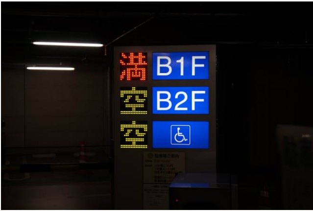
C 満車／空車を示すサイン 駐車場出入口での満車の表示は、一般向けと車いす使用者用駐車施設で分けて表示される。
