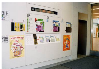
B 風除室 触知案内板が設置され、インターホンが組み込まれている。
