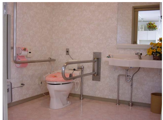
F 多機能便房 車いす使用者に配慮されている便房となっている。
