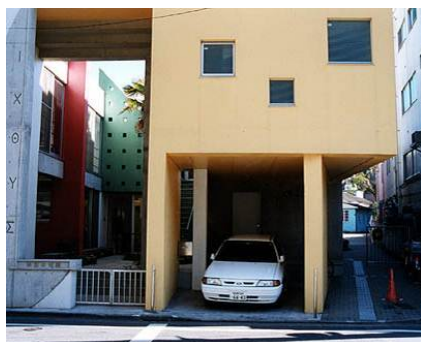
A 道路からの全景
