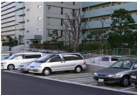
D 駐車場から傾斜路を見る
