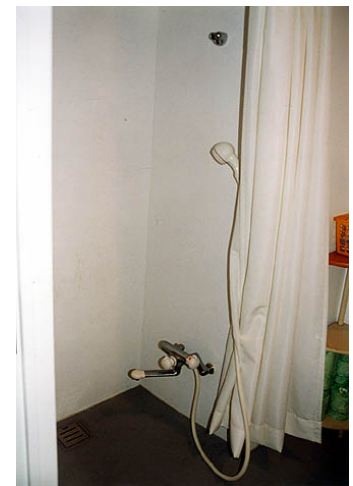
H シャワーコーナー 多機能便房内にシャワーコーナーを設けている。
