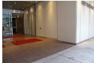
C 南館2階のスロープ レストランを配置した南館2階の段差解消のためスロープを設置。
