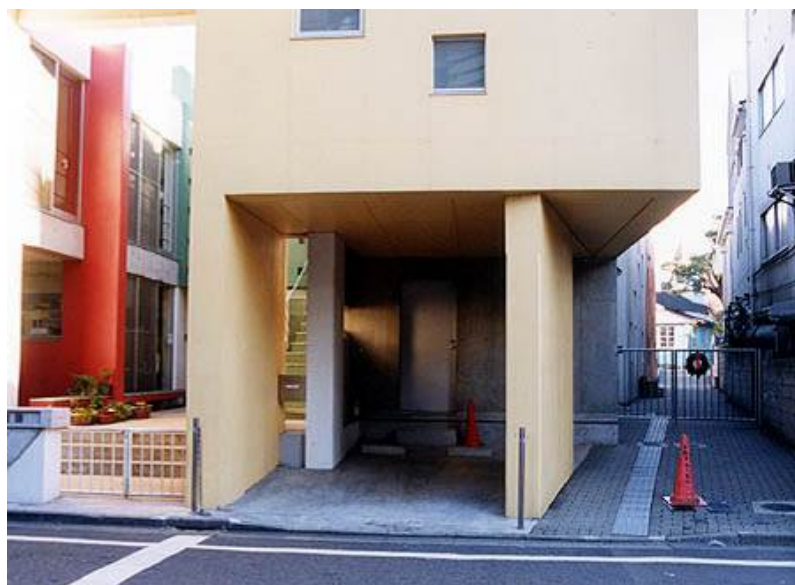
C 正面玄関横の障害者用通路
