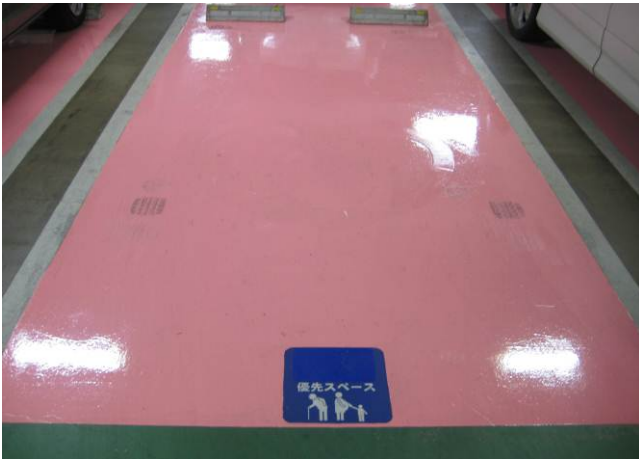
E 優先スペース 車いす使用者等以外の利用者で、エレベーターに近い位置の利用が必要な人のための駐車スペース。一般と同様の寸法であるが、色を塗り分けてある。
