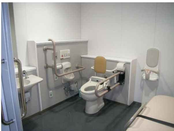
H 4階多機能便所 右勝手の多目的便所で、ユニバーサルシートが設置されている。
