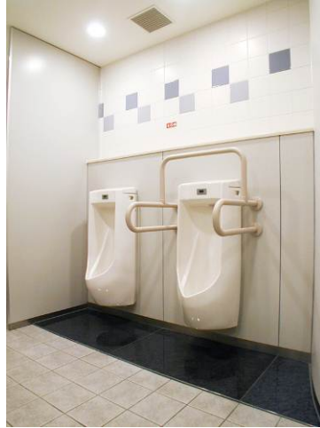
E 男性用便所の小便器便房 3階男性用便所の小便器にも手すりを設けている。
