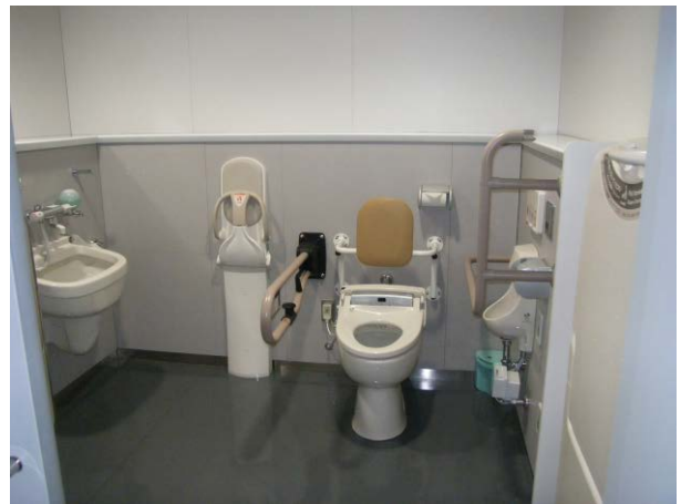
G 3階多機能便所 左勝手の多目的便所で、オストメイト対応となっている。また、ベビーシートが設置されている。
