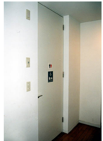
F 多機能便房入口
