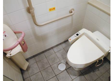
F 男性用便所の大便器便房 3階男性用便所の大便器便房にも乳幼児用いすを設けている。
