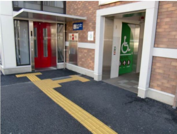
D 視覚障害者誘導用ブロック 駅改札口から公衆便所の案内表示板及びエレベーターまで、視覚障害者誘導用ブロックを敷設している。
