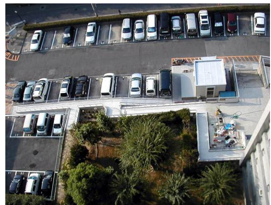
C 改修後の傾斜路
