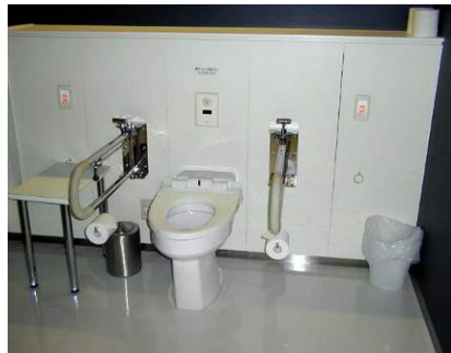
K 多機能便房 左右勝手を考慮して、各階に男女共それぞれ1か所ずつ設置。全ての便房に手すり、洗浄ボタン、呼び出しボタン、大型ベッド装備。背もたれ(7階)、感知センサー付き洗浄ボタン(2階)もある。 (上右) 折りたたみ式大型ベッド (上左) 2階便所内部 (右) 2階女性用便所平面図
