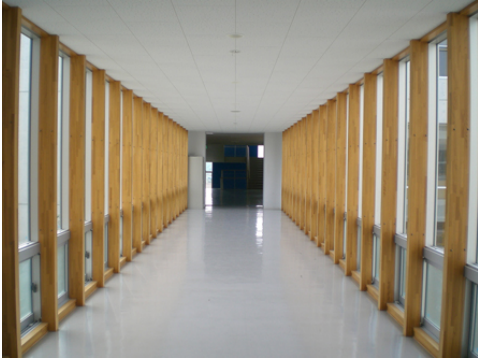
C 渡り廊下 (内部)
