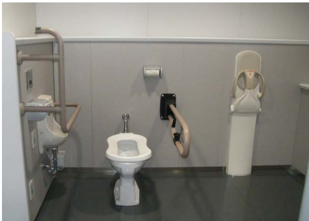
F 2階多機能便所 右勝手の多目的便所で、細長型の便器となっている。
