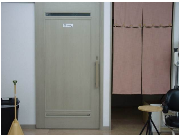
E 便所出入口とスタッフルーム出入口まわり 床に段差のない仕様となっている。
