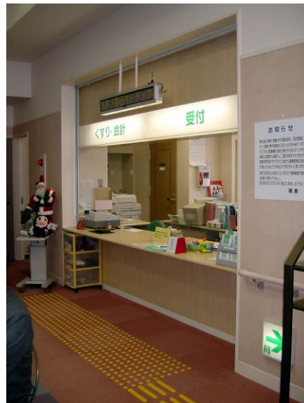
E 受付までの連続した誘導 高さ 750mm のカウンター。電光表示による案内・情報提供がなされている。
