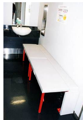
K 大型ベッド（収納式） 付多機能便房
