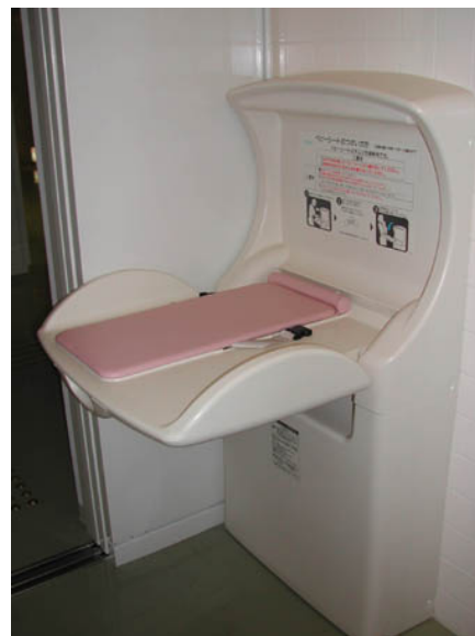
H 多機能便房 乳幼児用ベッドが設置されている。
