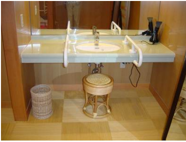
G 貸切浴室（脱衣室洗面台） 天板下を開放し、車いす使用者 者対応となっている。手すりも 設けられている。
