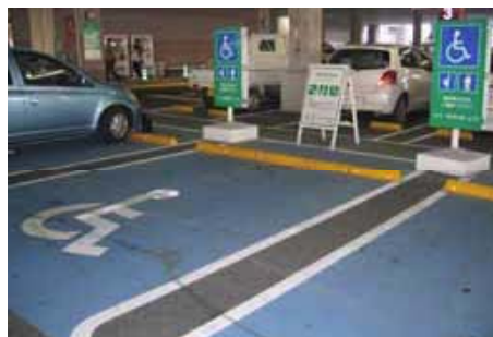
車いす使用者用駐車施設等の例
