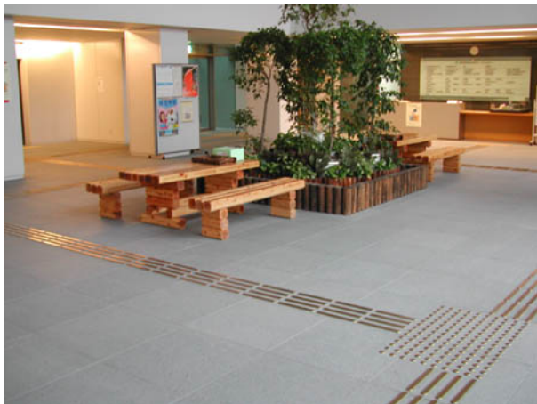
E ホール入口 視覚障害者誘導用ブロックは右が受付へ、左はエレベーターホールへ導いている。
