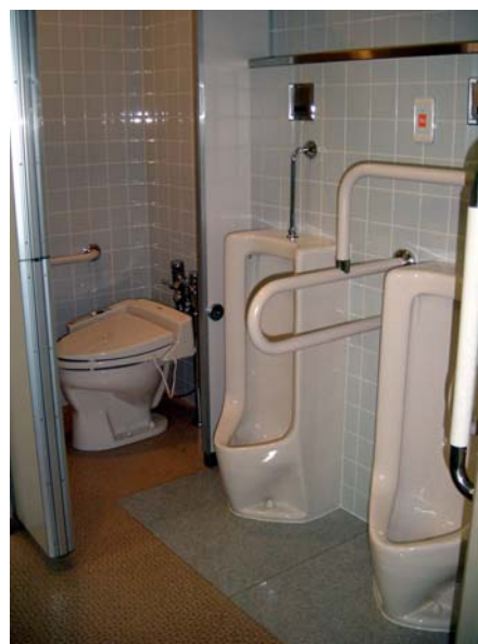
G 便所(男子用) 小便器、大便器共に手すりを整備している。
