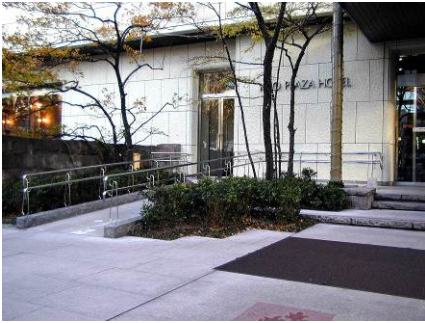
A 北側入口 増設された北側入口のスロープ
