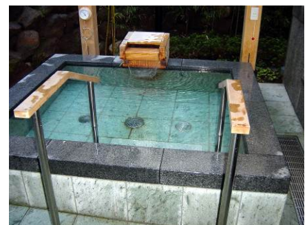
L 貸切浴室（露天風呂） 高齢者、障害者等が使いやすい ように、跨ぎ越しを低くし、手すりを設置。
