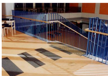
E 階段への誘導のための床の貼り分け
