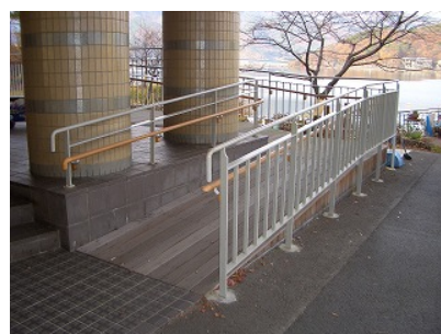
B 玄関前の(手すり付き)スロープ増設
