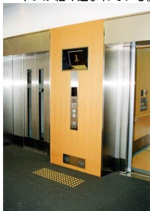
D エレベーター 手話の画面表示、手で操作するボタン、足で操作するスイッチが併設されている。
