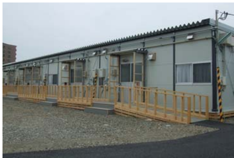
ii) スロープの設置例
