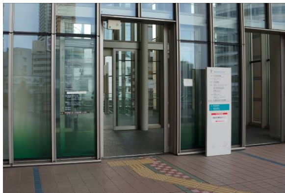
・視覚障害者誘導用ブロックの敷設と併せて、音声案内設備が設置されている建築物の出入口
