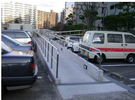
A 傾斜路 改修後なだらかになった状態。
