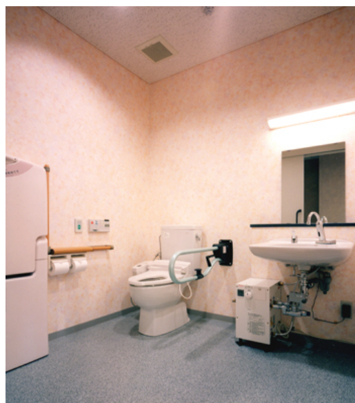
F 多機能便房 折たたみ式の乳幼児用ベッドが設置されている。
