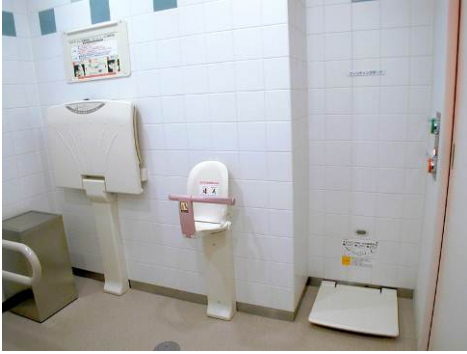
D 多機能便房 乳幼児用いす、乳幼児用ベッド、着替え台を3階に設けている。
