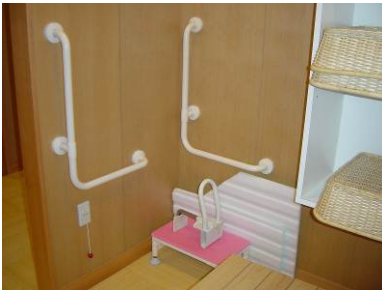
H 貸切浴室（脱衣室） 手すりを設置。浴室内で使用 可能な手すりやバスボードがあ り、ソフト面での細かい配慮が 伺える。
