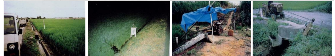
〔末端地域における番水〕配水が困難な下流側より白旗を立て取水水田を示しながら実施。 〔末端地域における番水〕番水は24時間体制で行われ、夜間の引水を末端水利組織が見回り確認。 〔仮設揚水ポンプの設置(耕耘機動力)〕用水路と分離している排水路に揚水ポンプを設置し、水の反復利用を図った。 〔仮設揚水ポンプの設置(トラクター動力)〕用水路と分離している排水路に揚水ポンプを設置し、水の反復利用を図った。
