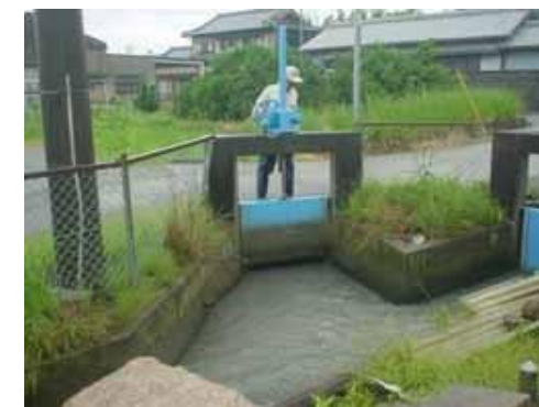
水利管理人による分水工ゲートの操作
