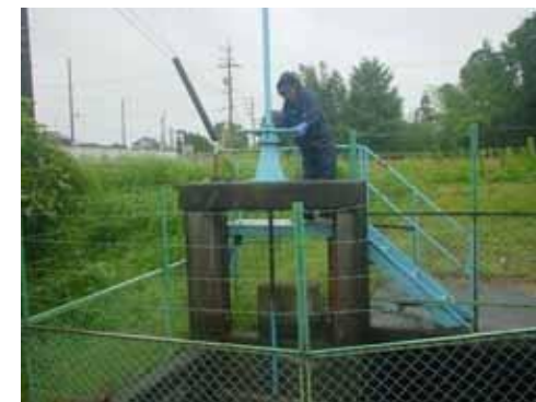
水利管理人による取水ゲートの操作
