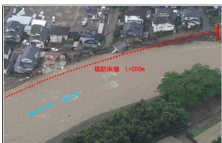
浸食により家屋が流失した状況
