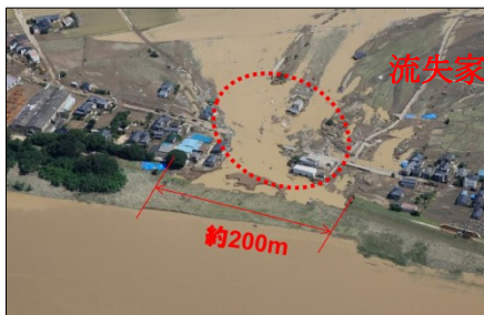
堤防決壊により家屋が流出した状況
