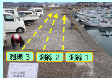
測線設定状況
