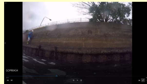
撮影事例(護岸) 変状確認
