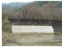
堤体前面に張りコンクリート
