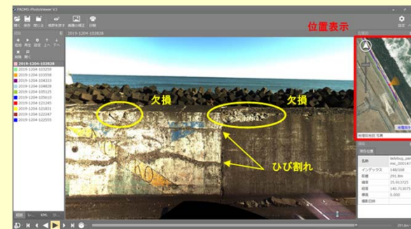
撮影事例(護岸胸壁) 変状の確認
