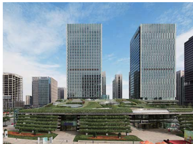
天津経済開発区 (TEDA) 複合施設 (中国) | TEDA MSD Complex (Tianjin, China)
