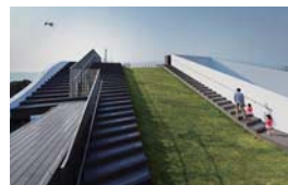
屋上広場 | Roof Garden
