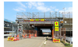
道路工事注意・建設工事注意
