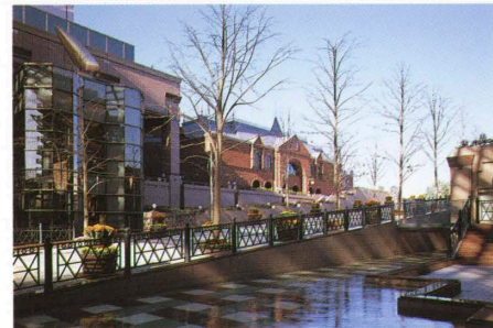
センタープラザへのスロープ Slope to the Center Plaza.
