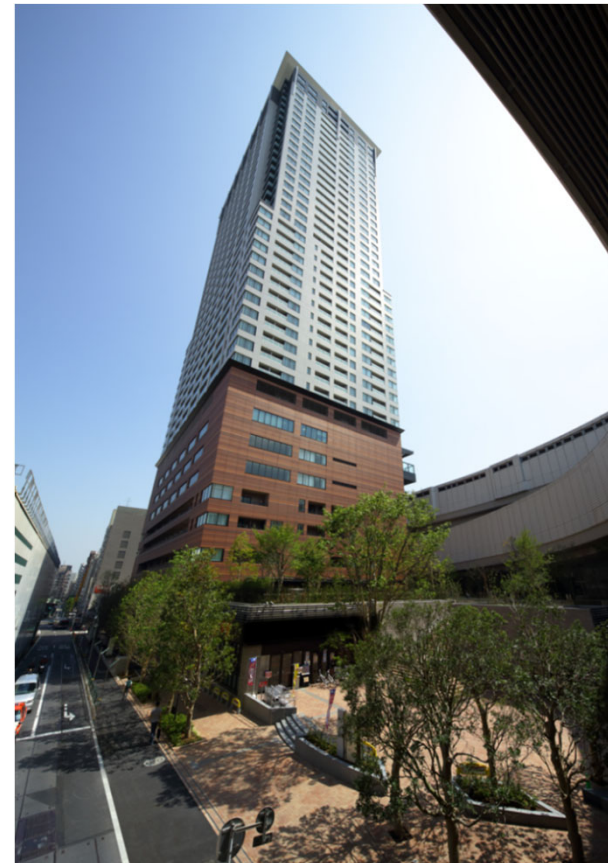
ファサードの三層構成と基壇部の「地層」
