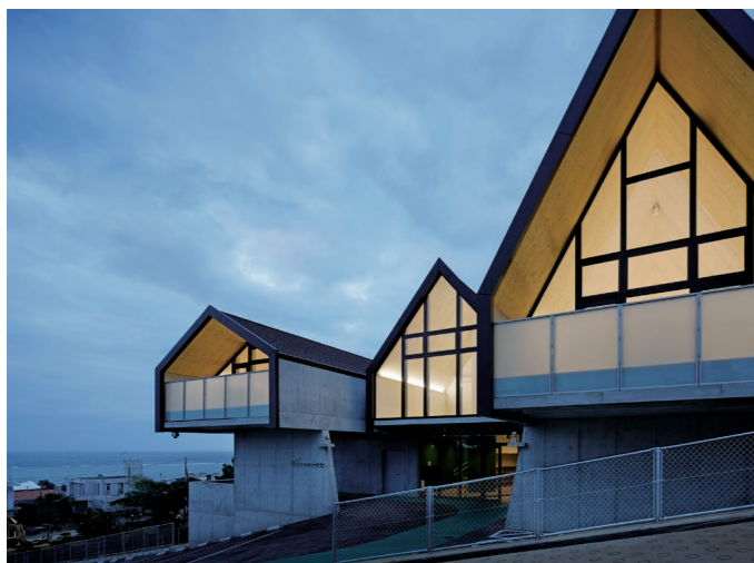
屋根の部材にCLTを使用している。こどもの森保育園(沖縄市)
