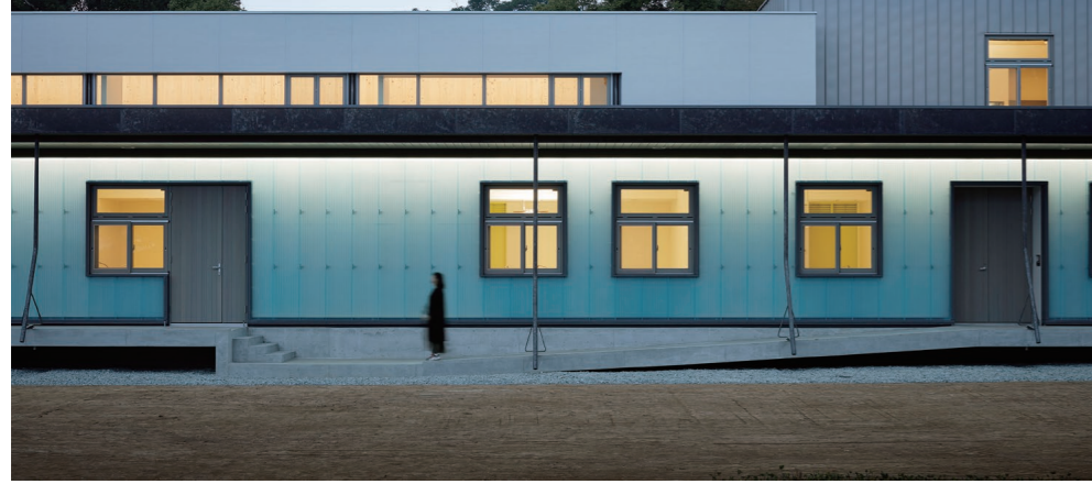
CLT準耐火仕様で計画された森林総合研究所九州支所(熊本市)
