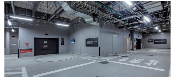
1号機・2号機：駐車場前面
