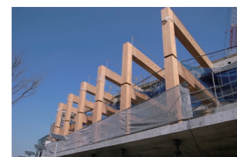
国内初の1時間耐火木材を使用した大規模商業施設,SOUTH WOOD(横浜市)
