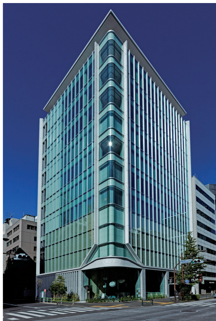
三甲新橋ビル 外観
