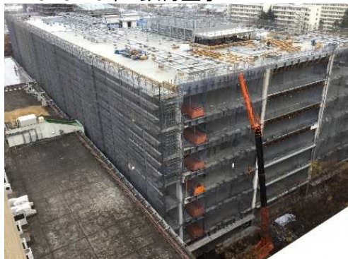
▲2019.3末 鉄骨工事完了
