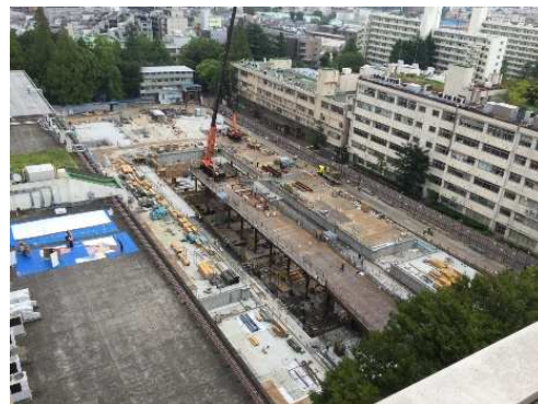
▲2018.08末 地下躯体工事
