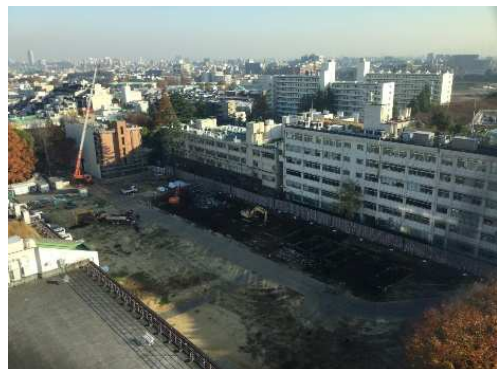
▲2017.11末 旧1号館基礎解体工事
