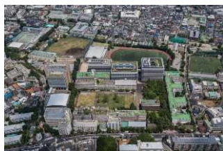
▲旧1号館解体後の世田谷キャンパス
