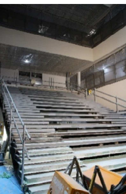
▲施工中の大階段
