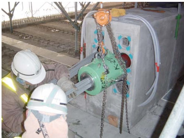
写真9 | 梁型付きPC版の横締めケーブル緊張
