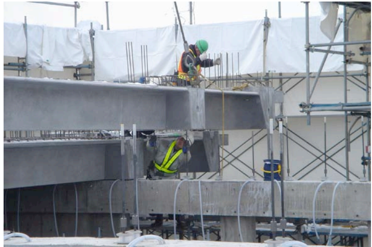
写真5 | PC版架設状況
