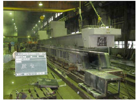
写真3 | PC 屋根版の製作状況
