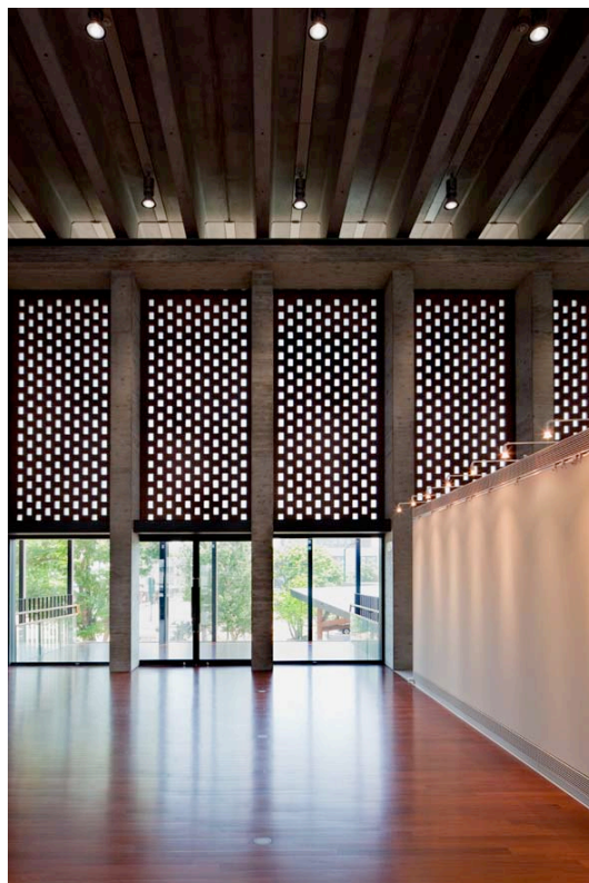
写真12 | 岩見沢複合駅舎のPC屋根版
