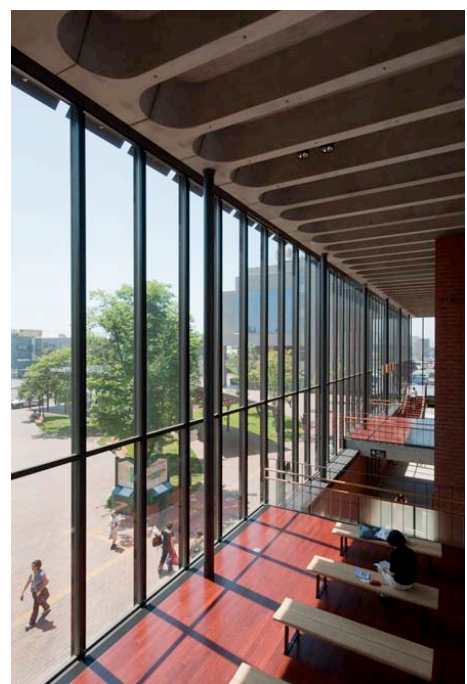
写真2 | PC屋根版に守られた内部空間
