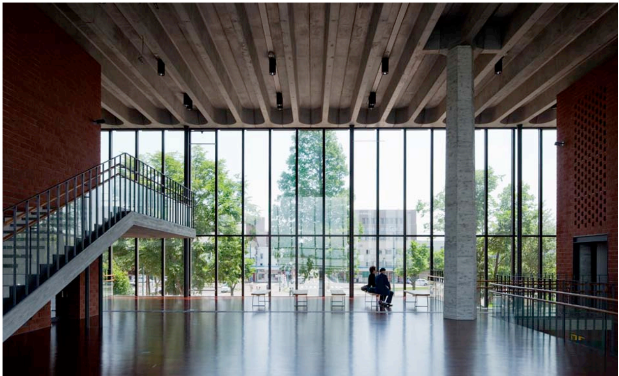
写真8 | 梁型付きPC版による吹き抜け空間 (センターホール)
