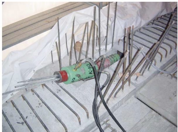
写真10 | 版両端部の横締めケーブル緊張
