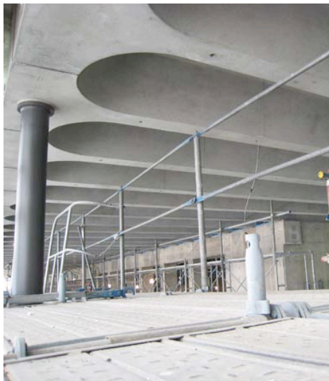
写真6 | PC版と鉄骨柱との取り合い
