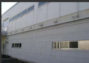
既存の外壁状況
