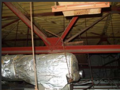
既存の鉄骨状況①
