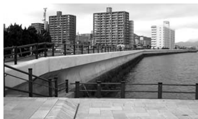
護岸（高松港海岸（香川県））
