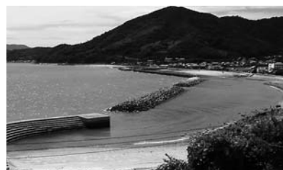
離岸堤（沖浦港海岸（山口県））
