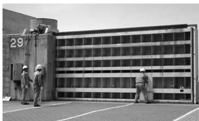
陸閘（大阪港海岸（大阪府））
