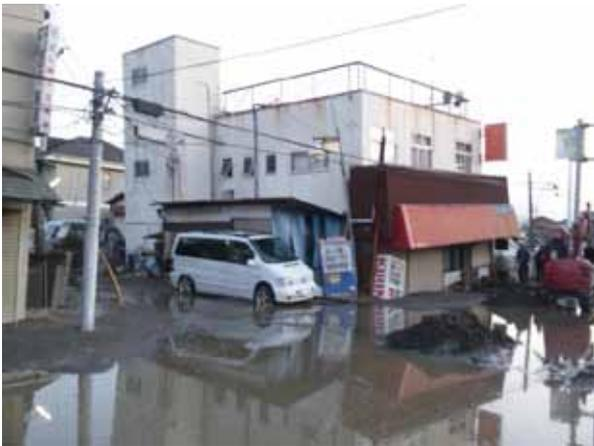
写真 1-3-6 家屋や電柱等の沈み込み
