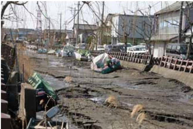
写真 1-3-2 液状化により川底が隆起している
