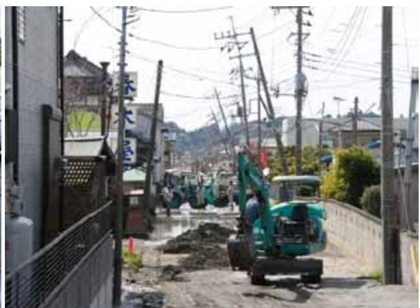
写真 1-3-9 噴出した砂の撤去
