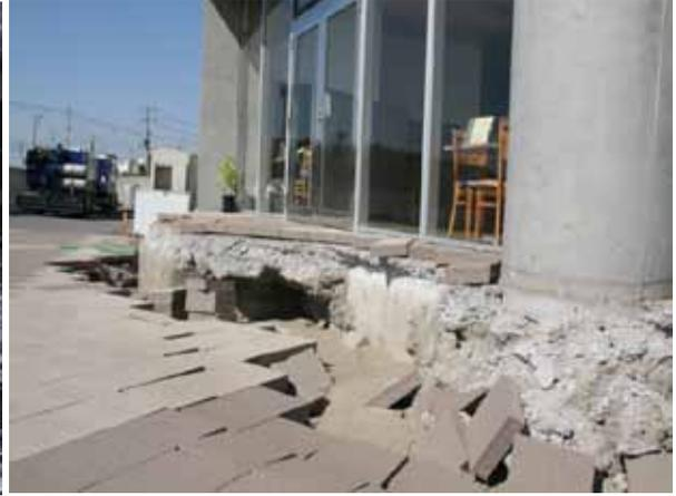
写真 1-3-5 液状化による抜け上がり
