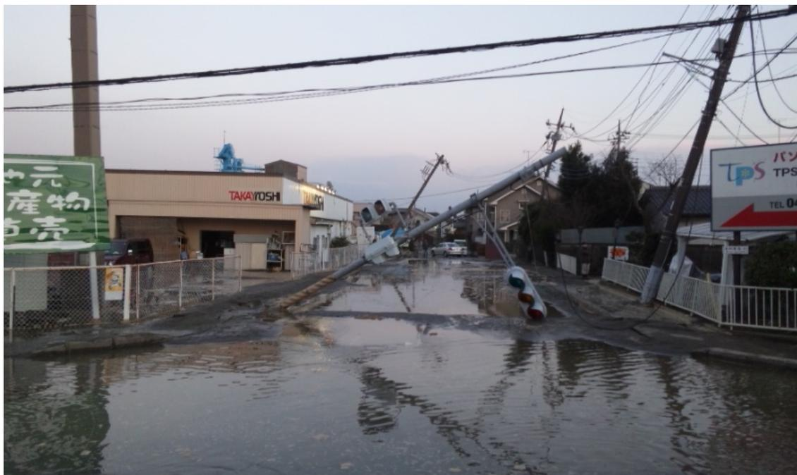
写真 1-3-3 泥水が噴出し電柱が傾く
