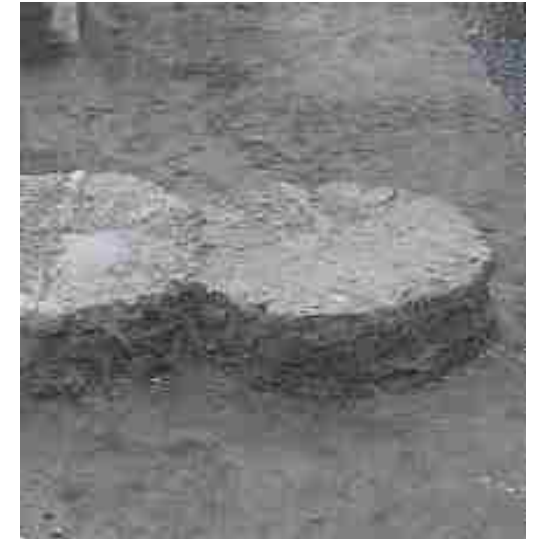
造成した改良体
