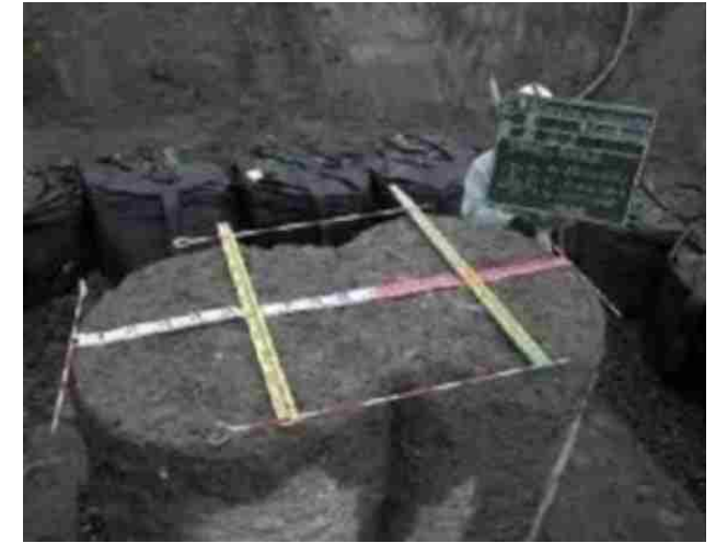
造成した改良体
