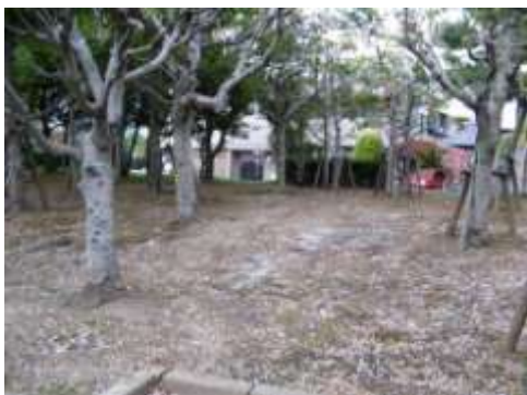
B タイプの被害部分. 今川公園の盛土上の噴砂. 4/20 撮影.
