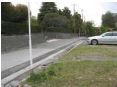
B タイプの被害部分. 今川記念公園. 盛土部分は周囲の道路とともに沈下している. 4/20 撮影.
