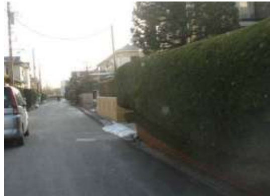
南西部のAタイプ~Bタイプの被害. 東西方向に波頭が延びる波長10~15mの地波. 3/18撮影.
