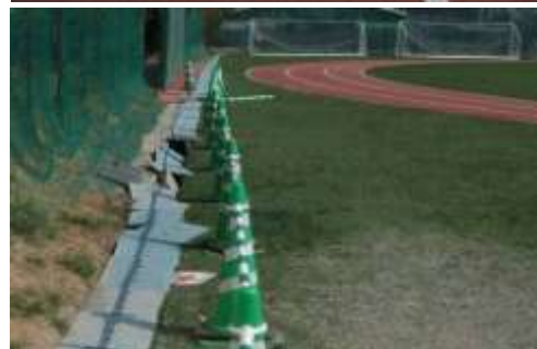
Bタイプの被害部分。グラウンドに張られたマットや人工芝が北東方向に20cm程滑った。4/11撮影。
