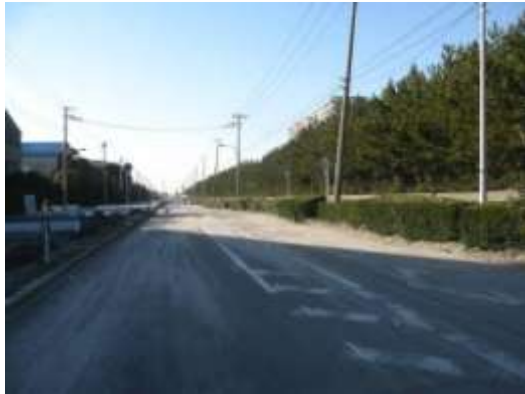
Bタイプの被害部分. 中央公園通にみられる地波と噴砂. 3/18 撮影.
