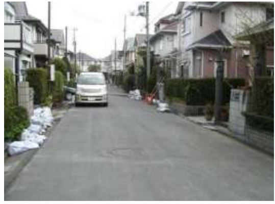
A タイプ~B タイプの被害部分. 道路より家のほうが20cm程度沈み込む. 4/19 撮影.
