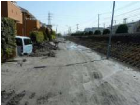
A タイプ~B タイプの被害部分. 中央公園通沿いの旧堤防の内側では、大量の噴砂を伴う. 3/13 撮影.
