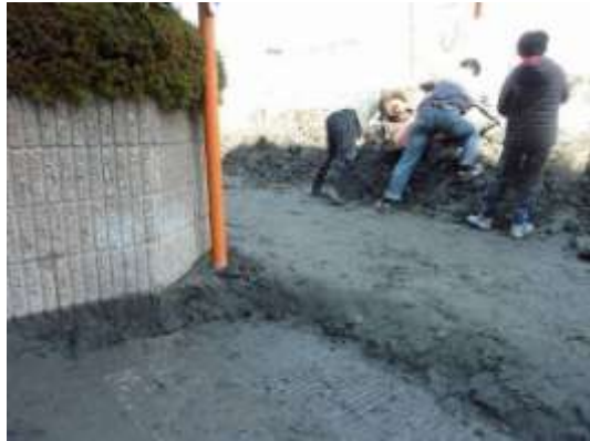
A タイプ～B タイプの被害部分. 大量の噴砂のため, 道路わきに砂をよせている. 3/13 撮影.
