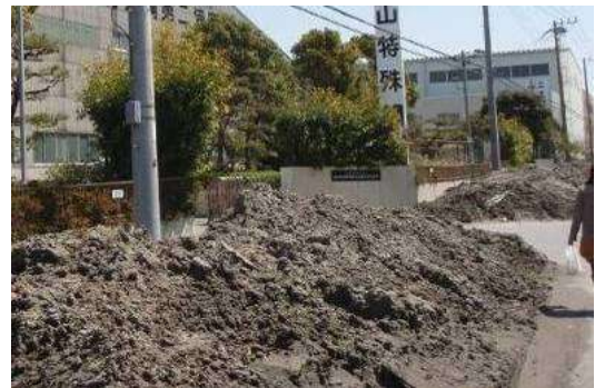
Aタイプの被害部分。路上に積まれた噴砂。4/12撮影。
