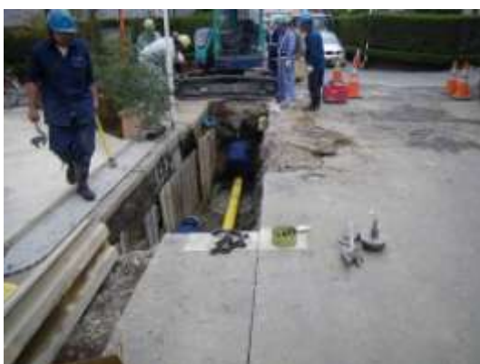
北東部の A タイプの被害部分. ガス本管の復旧工事. 黄色の管は7倍の伸びに耐えられるとのことである. 水位はGL-1.5m. 4/21 撮影.
