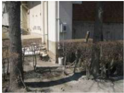
A タイプの被害部分. マンションの抜け上がりと破断した樋管. 4/5 撮影.
