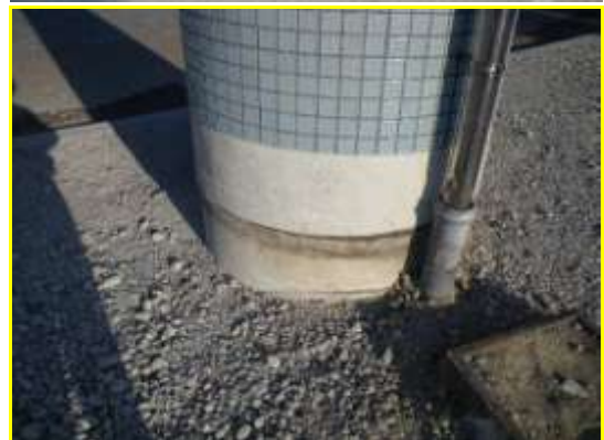
A タイプの被害部分. 舞浜駅前の歩道橋の橋脚の 40cm を超える抜け上り. 4/13 撮影.
