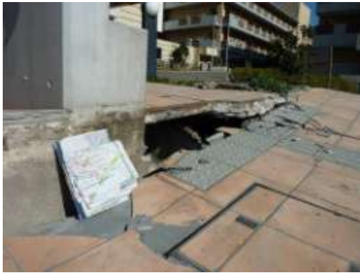
Aタイプの被害部分。ビルの40cmを超える抜けあがり。 3/13撮影。
