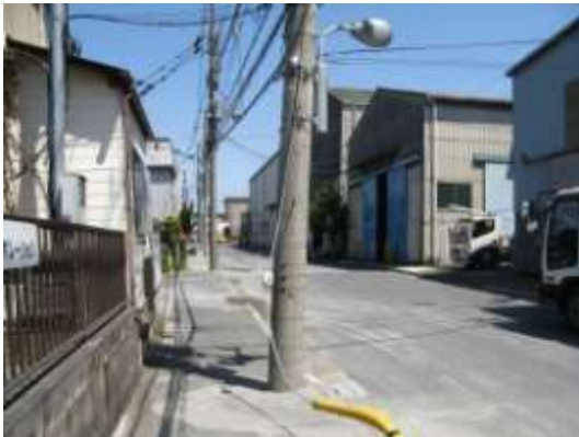
Aタイプの被害部分。電柱が大きく沈み込んだ。4/12撮影。
