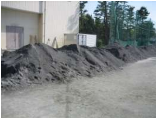
A タイプの被害部分. 見明川中学校体育館脇に片付けられた噴砂の山. 3/12 撮影.
