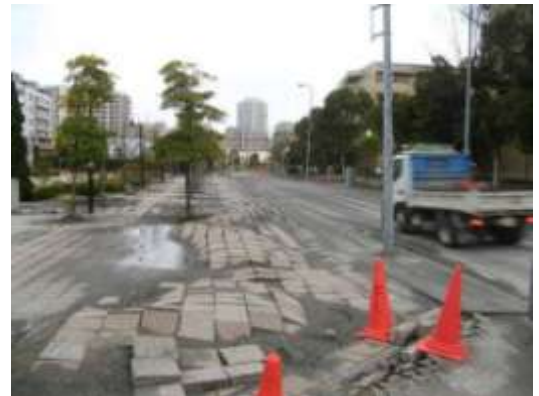
A タイプの被害部分。おひさま公園南の道路の歩道に残る地波。東西方向に延びる地波が食い違っつながっている。3/23 撮影。
