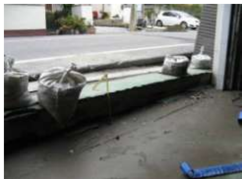
Bタイプの被害部分。コンクリート製車庫が30cmほど沈み込んだ。4/20撮影。
