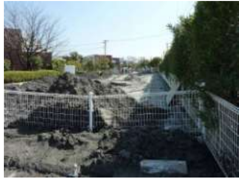
A タイプ～B タイプの被害部分. 中央公園通沿いの駐車場にみられた大きな沈下と大量の噴砂. 後片付けで集められた大量の噴砂. 3/13 撮影.
