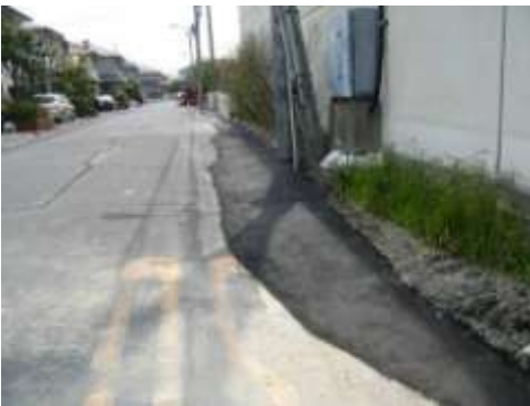
B タイプの被害部分の中に局所的にみられる A タイプの被害部分. 局所的なので図に示すのが困難である. 30cm程度の沈下が道路にみられる. 上は4/21, 下は4/27撮影.
