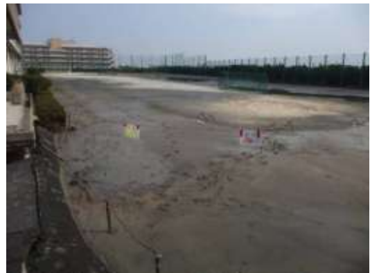
Aタイプの被害部分. 浦安南高校の沈下した校庭には噴砂と泥水が溜まった. 3/25 撮影.
