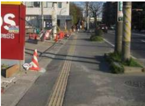
A タイプの被害部分. ガソリンスタンドとその周辺の地表の変形. 4/5 撮影.
