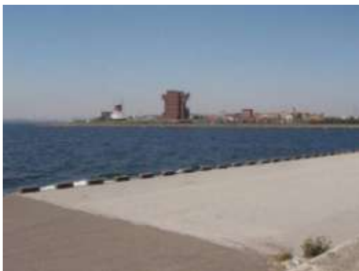
船着場には噴砂や変形もなく液状化していないと思われる. 4/13撮影.
