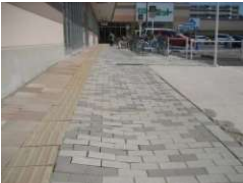
A タイプの被害部分. 中央公園通に沿う店舗敷地内の歩道の変形. 4/5 撮影.
