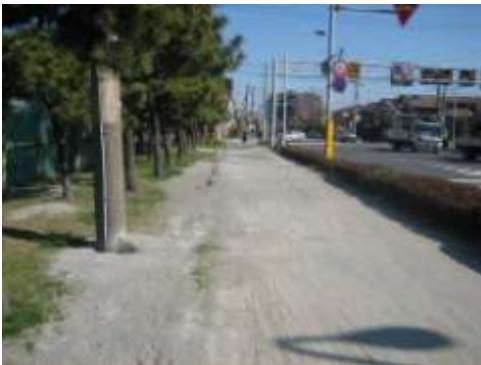
A タイプの被害部分. 中央公園前の道路上の噴砂跡. 正面方向に京葉線線路がある. 4/5 撮影.
