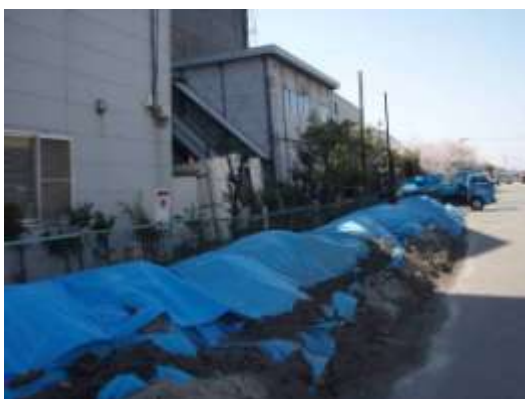
Aタイプ～Bタイプの被害部分。路上に積み上げられた噴砂。4/12撮影。
