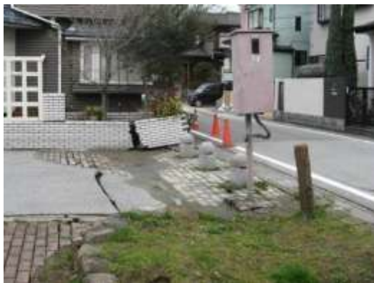
A タイプの被害部分. 道路わき部分の沈下と噴砂. 3/23 撮影.
