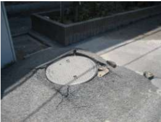
B タイプの被害部分. 抜け上がったビルの前 の浮上したマンホール. 3/13 撮影
