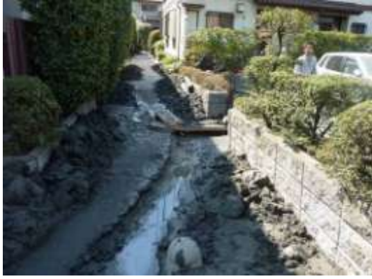
A タイプ～B タイプの被害部分. 大量の噴砂. 3/13 撮影.
