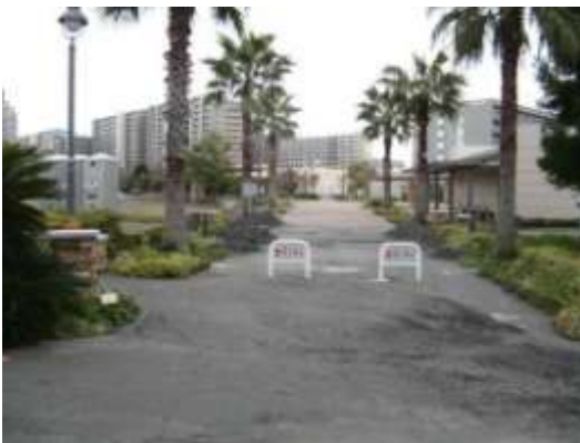
おひさま公園入口付近では噴砂が多く地表面の変形も大きい A タイプの被害. この奥に進むにつれ噴砂や変形は急速に小さくなり C タイプに変化する. 3/23 撮影.
