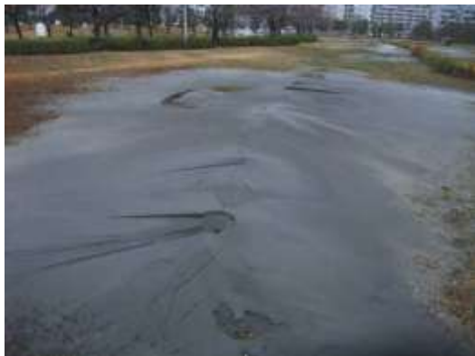
A タイプの被害部分. 大規模な噴砂丘. 3/22 撮影.
