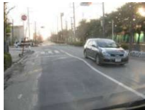
Aタイプの被害部分。中央公園前の道路の地波。3/18撮影。
