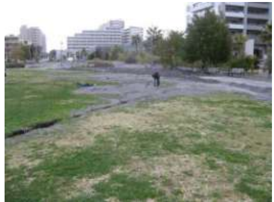
A タイプの被害部分。おひさま公園南西部。東西方向に延びる亀裂。A タイプの液状化〜流動化部分。3/23 撮影。
