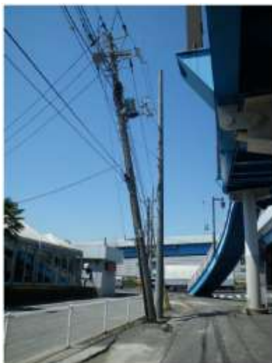
Bタイプの被害部分。電柱の傾動。4/13撮影。
