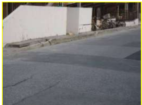
Aタイプの被害部分. 北東-南西方向の道路の南東側の側溝の浮上. 道路の高さの低い側にあたる. 4/16 撮影.
