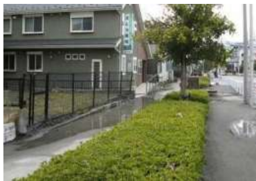
A タイプの被害部分. 歩道部分にみられる地波と噴砂. 地波の波頭は東西方向に延びる. 3/23 撮影.
