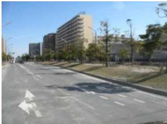
A タイプの被害部分。シンボルロード上のゆるやかな地波。波長 15m 程度で波頭が東西方向に延びる。3/18 撮影。
