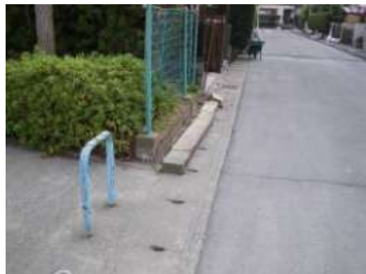
Aタイプの被害部分. 北東-南西方向の道路の南東側の側溝の浮上. 道路の高さの低い側にあたる. 4/16 撮影.
