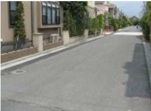
中央～西部付近の B タイプ部分中の地波. コンクリート塀が沈みこみ・傾動. 5/17 撮影.
