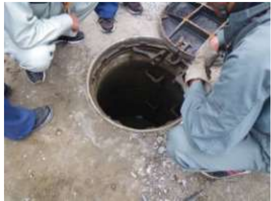
北東部の A タイプの被害部分. 下水道本管のマンホールは上部ほど南東(道路)側へずれている. 4/21 撮影.
