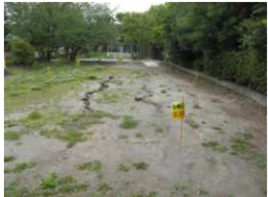
B タイプの被害部分. 南西端の公園内. 南東方向の亀裂とこれに伴う噴砂. 5/17 撮影.
