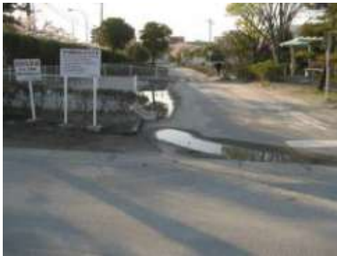
A タイプ～B タイプの被害部分. 中央公園通沿いでは, 地波を伴う大きな地表の変形を伴っている. 4/12 撮影.
