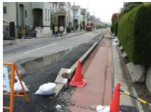
A タイプの被害部分. 舞浜入口の道路沿い. 歩道は沈下し, その脇の戸建て住宅は地中に沈み込んでいる. 4/19 撮影.
