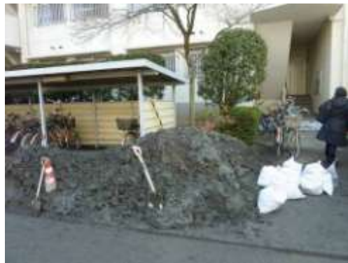
A タイプの被害部分. 中央公園通に沿って大量の噴砂があった. 3/13 撮影.
