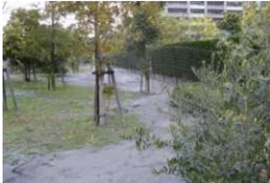
A タイプの被害部分。おひさま公園南東端での著しい噴砂と地波および地盤の沈下。噴砂は青灰色の細粒砂〜極細粒砂である。3/23 撮影。
