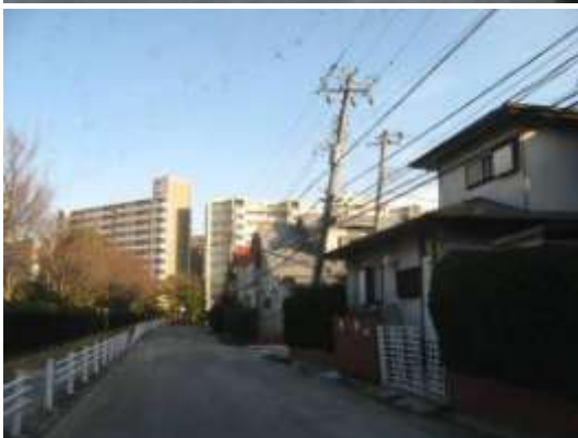
南西部での A タイプの被害. 電柱・レンガ積み塀の傾きを伴う沈み込みがみられる. 住宅にも沈み込み・傾動がみられる. また, 地波もみられる. 3/18 撮影.
