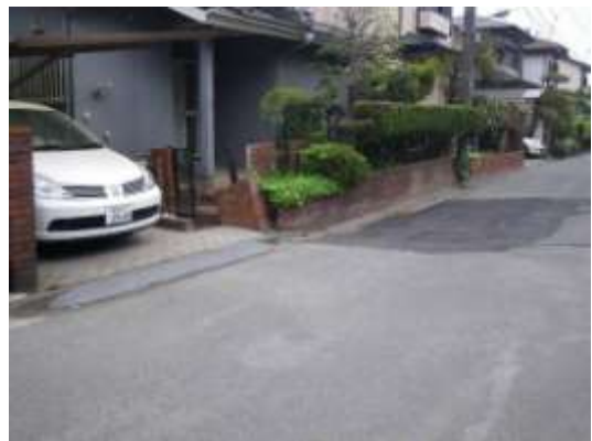
北東部の B タイプの被害部分. 門柱・塀の傾動を伴う沈み込みと, 道路の沈下. 4/21 撮影.
