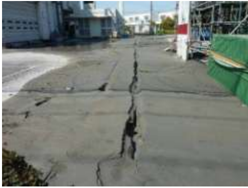
A タイプ～B タイプの被害部分. 消防署裏の亀裂と噴砂. 亀裂と噴砂は北西方向に長く連続する. 3/13 撮影.
