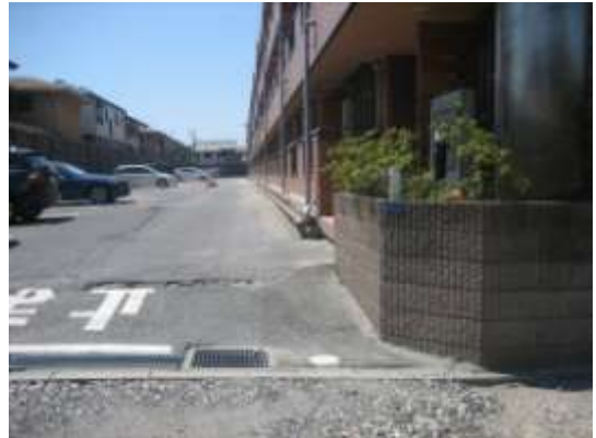
B タイプの被害部分. 抜け上がったビル周辺の戸建て住宅 の一部には傾斜などの被害がみられた. 3/13 撮影.
