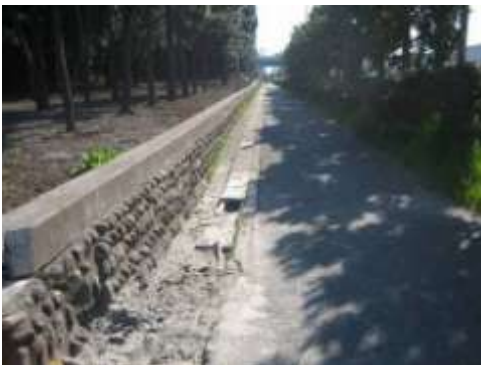
A タイプの被害部分. 中央公園の崩れた石垣. 右側は首都高速湾岸線. 4/5 撮影.
