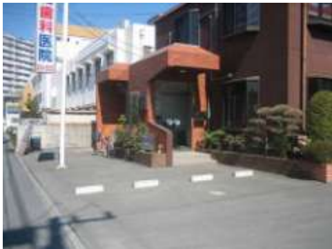
上記の A タイプの被害部分に隣り合うようにみられる小規模な C タイプ～D タイプの低被害部分. 隣の白い建物も含めて抜け上がりはみられなかった. 4/5 撮影.
