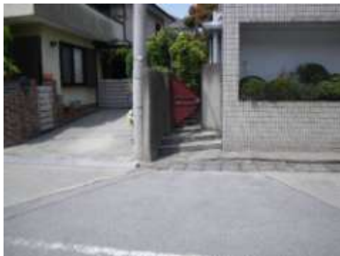
B タイプの被害部分. 右側の家は抜け上りがみられ杭基礎があり、左の家は杭がなく沈下していると考えられる. このためこれらの境界部の階段は傾いている. 4/21 撮影.
