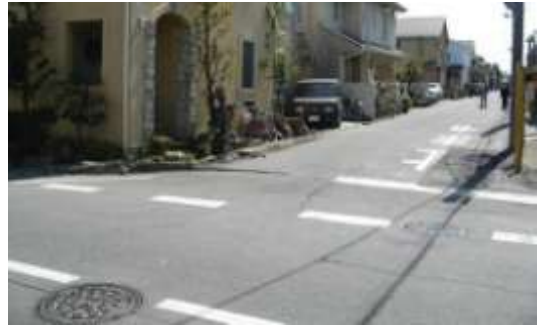
B タイプの被害部分. 戸建て住宅が20~30cm程度沈み込んでいる。側溝が波うつ。4/14撮影。
