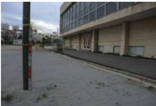
B タイプの被害部分. 入船北小学校の護岸に隣接するグラウンドは多量の噴砂に覆われ沈下・変形した. 4/8 撮影.
