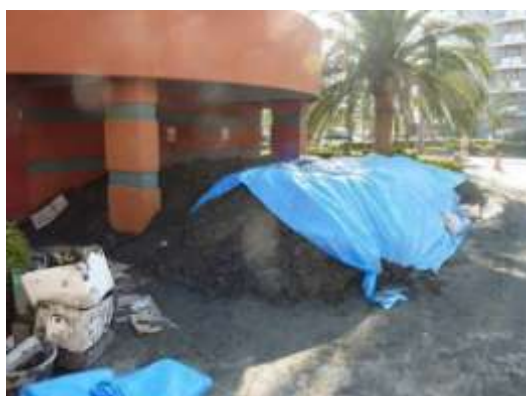
A タイプの被害部分. 片付けで集められた噴砂. 3/13 撮影.
