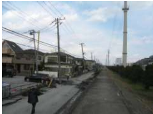
A タイプの被害部分. 南東端の旧護岸沿い. 大量の噴砂があり電柱が傾いた. また, 戸建て住宅とコンクリート塀が数十 cm 沈み込んでいる. 3/23 撮影.
