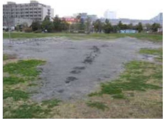
A タイプの被害部分。おひさま公園南西部の築山に囲まれた低地部分。低地に噴砂が多くみられる。北西方向の亀裂から噴砂している。A タイプの液状化〜流動化部分。上下ともに3/23 撮影。
