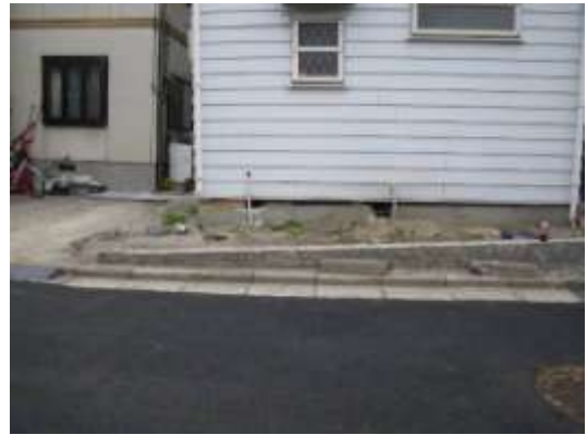
A タイプ~B タイプの被害部分. 家屋の修復例. 沈み込んだ基礎と上屋との間に木材を挿入している. 過去の他地域の被害の際にもこの方法で修復していた. 5/16 撮影.
