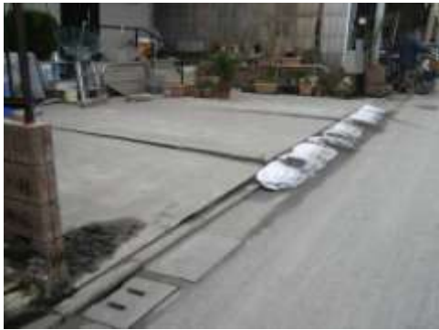
B タイプの被害部分. 家の前の駐車スペースの傾き. 左奥の戸建て住宅も同様に数度傾き, 居住困難とのことである. 3/23 撮影.
