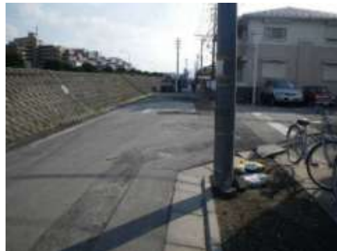
B タイプの被害部分. 護岸沿い道路の相対的盛り上がり. 護岸周囲の沈下と家屋の沈下により, 道路中央部が盛り上がったように見えるものと思われる. 4/20 撮影.
