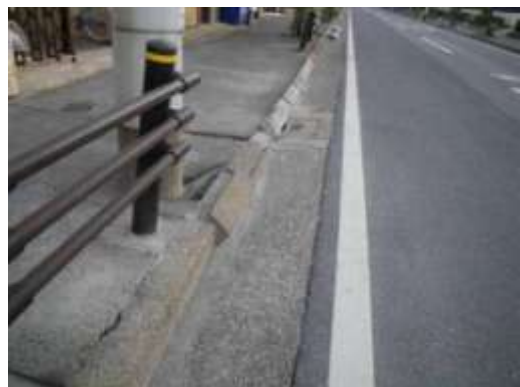
Bタイプの被害部分. 公園の縁石の転倒. 押さえのない道路側へ転がる. 上下とも 4/16 撮影.
