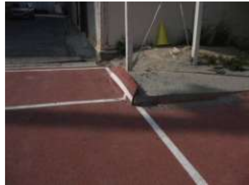
Bタイプの被害部分。噴砂を伴う沈下により、基礎のある校舎は20cm程度の抜け上がりを生じた。4/11撮影。
