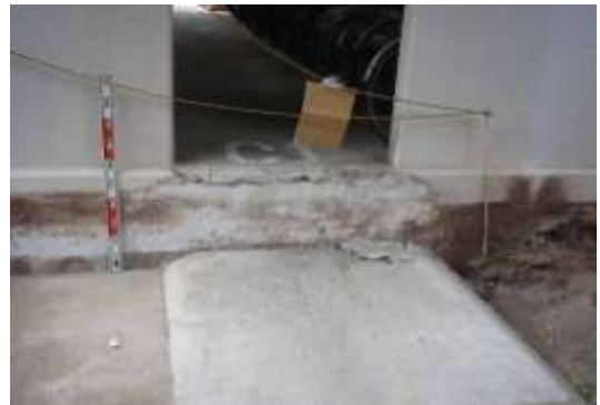
A タイプの被害部分. 中層ビルにみられる抜け上がりによる段差. 抜け上がり量は約45cm. 4/7 撮影.
