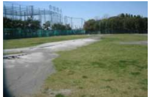
A タイプの被害部分. 中央公園グラウンドの噴砂列. 南東方向の延長上の富岡 3 丁目には被害の大きい場所が連続する. 4/12 撮影.
