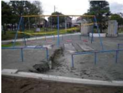
B タイプの被害部分. 今川公園での防火水槽周囲の浮上. 構造物周囲でより大きな沈下. 4/20 撮影.
