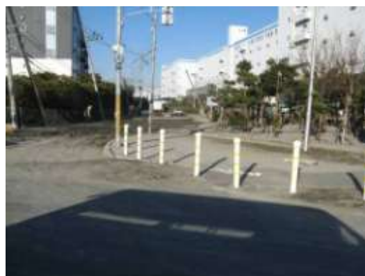
Aタイプの被害部分. 千鳥町中央部の大量の噴砂と電柱の傾き. 3/18撮影.
