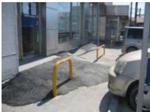
A タイプの被害部分. 30cmほど抜け上がったビルの入口. 4/5 撮影.
