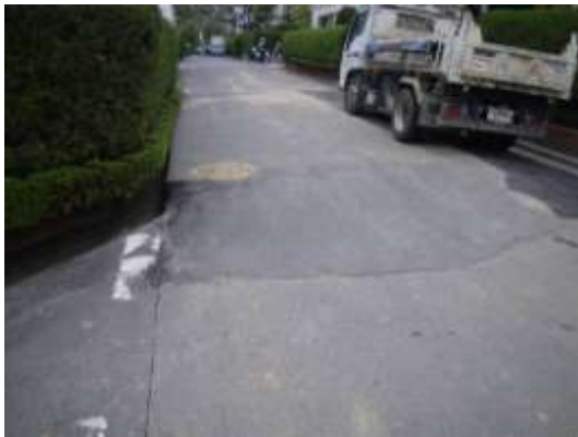
A タイプの被害部分. 道路下の防火貯水槽の浮上. 4/21 撮影.
