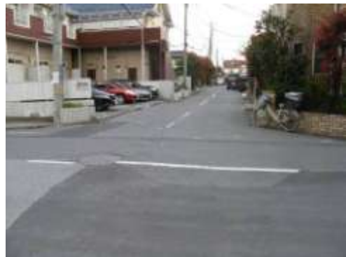
Bタイプの被害部分。波長20mの地波。4/20撮影。
