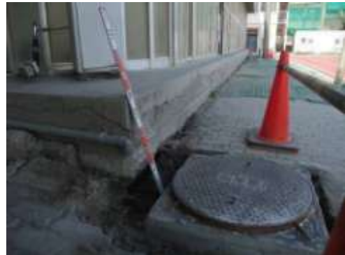
Bタイプの被害部分。噴砂を伴う沈下により、基礎のある校舎は20cm程度の抜け上がりを生じた。4/11撮影。
