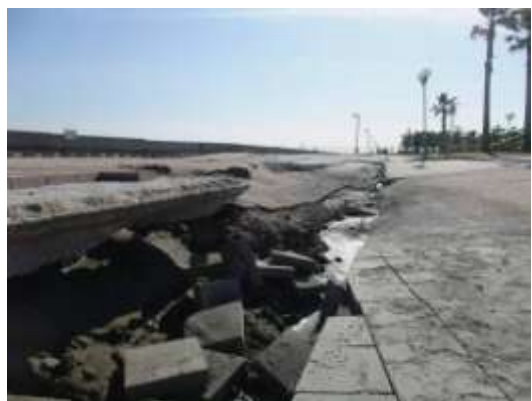
A タイプの被害部分。護岸の内側には開口亀裂が顕著に認められた。3/18 撮影。
