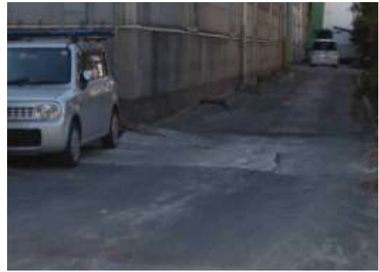
Aタイプの被害部分. 基礎の抜け上がり. 4/12 撮影.
