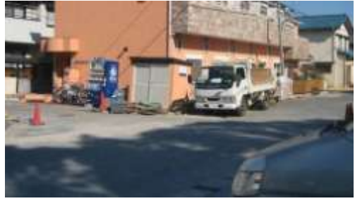
A タイプの被害部分. 傾いた物置. 4/5 撮影.
