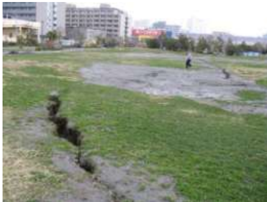
A タイプの被害部分。おひさま公園南西部。東西～北西方向の亀裂。高いところでは噴砂量が少ない。斜面にあり、地すべりを伴い亀裂が開いている。3/23 撮影。
