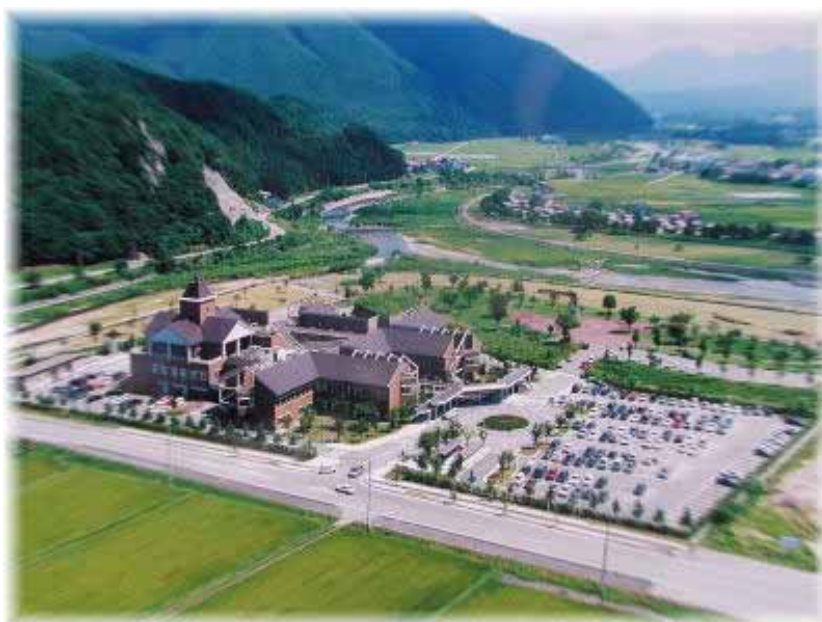
県立南会津病院遠景
