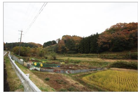
⑳周辺の道路から北側未供用区域を望む。西斜面しか見えない
