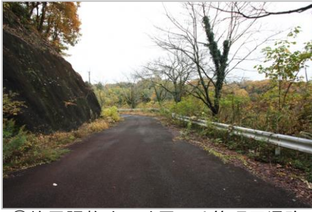
⑪蜂屋調整池の外周には管理用通路が一部整備され、池を周遊できる
