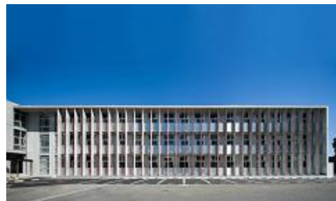
水戸第二高校普通・特別教室棟新築復旧工事
