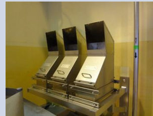
静的触媒式水素再結合装置(PAR)
