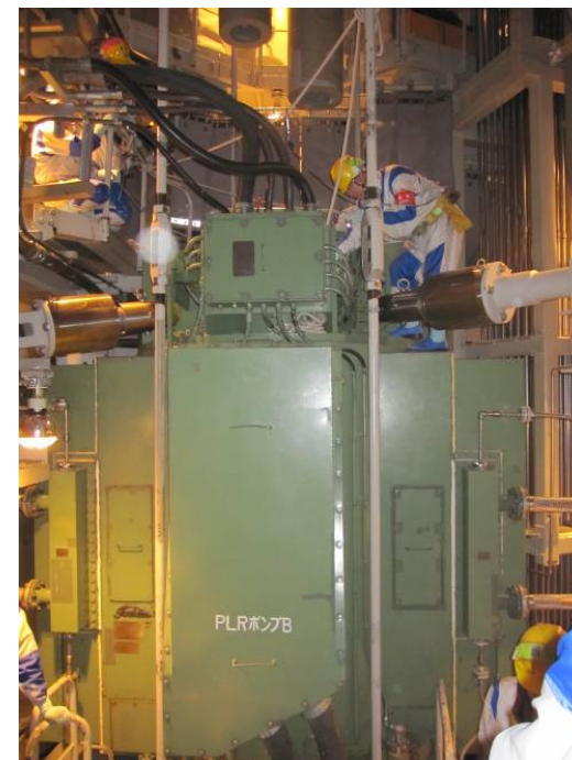
原子炉冷却材再循環ポンプ(B) 電動機の運転状態の確認
