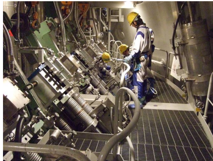
主蒸気隔離弁
